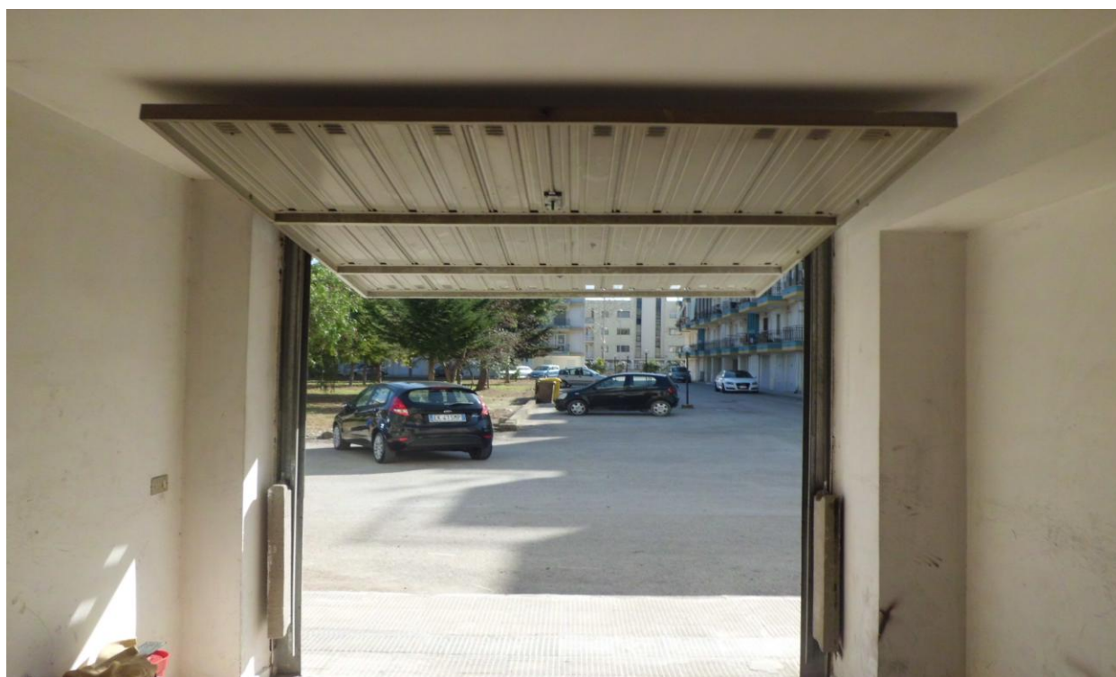
FOTO N. 5 – PARTICOLARE INGRESSO - PRESA INTERNA
