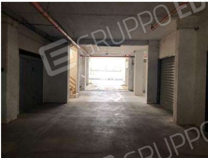
Garage interrato in cui si trova il box auto
