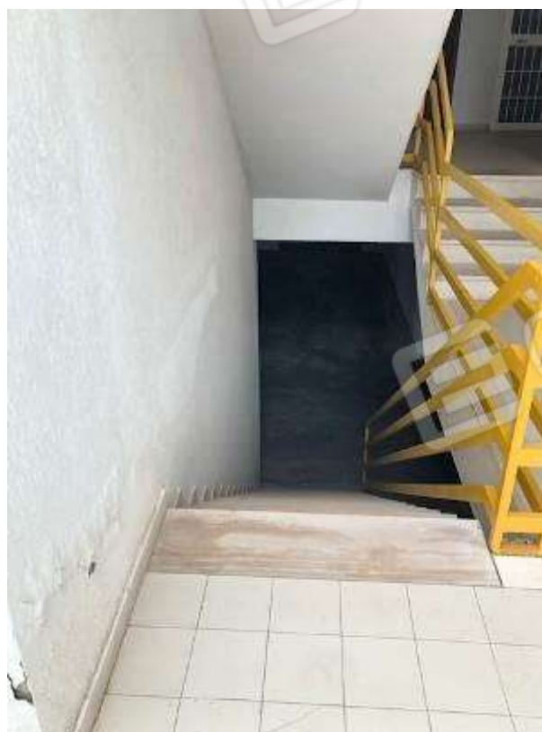
Vano scale comune che porta all'interrato e al piano rialzato
