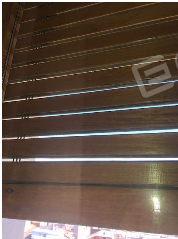
Dettaglio dell'avvolgibile esterno in legno
