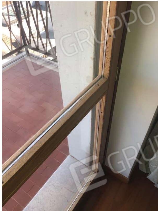
Dettaglio del serramento esterno
