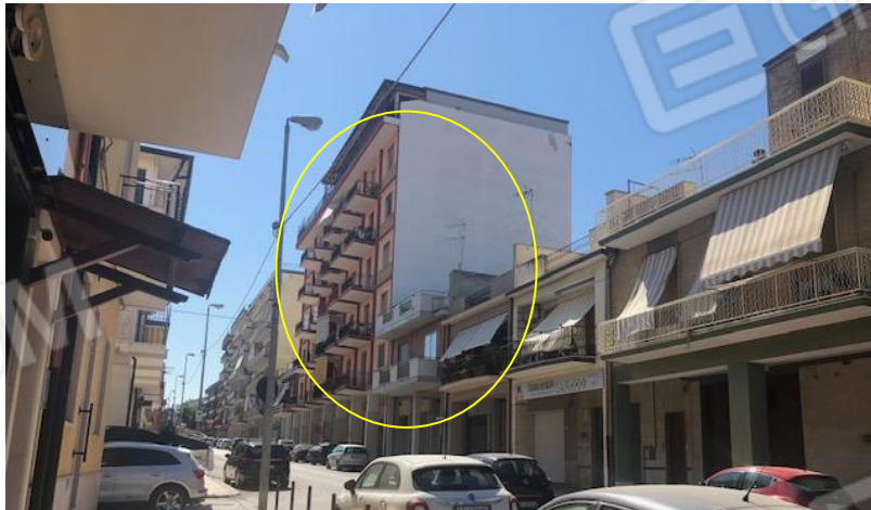
Vista della palazzina cui appartiene il bene pignorato da Viale Aldo Moro
