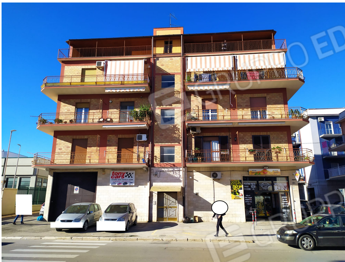
FOTO N.1 – Prospetto di facciata su V/le Di Ponente
