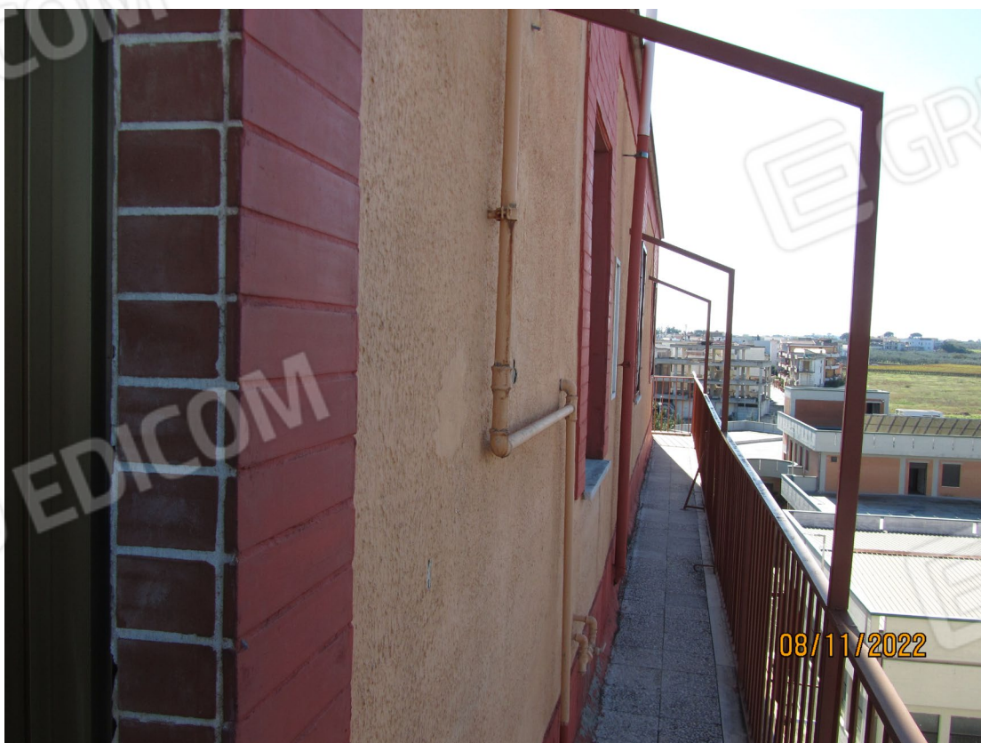
FOTO N.6 – Balcone con affaccio su via Vallebona.
