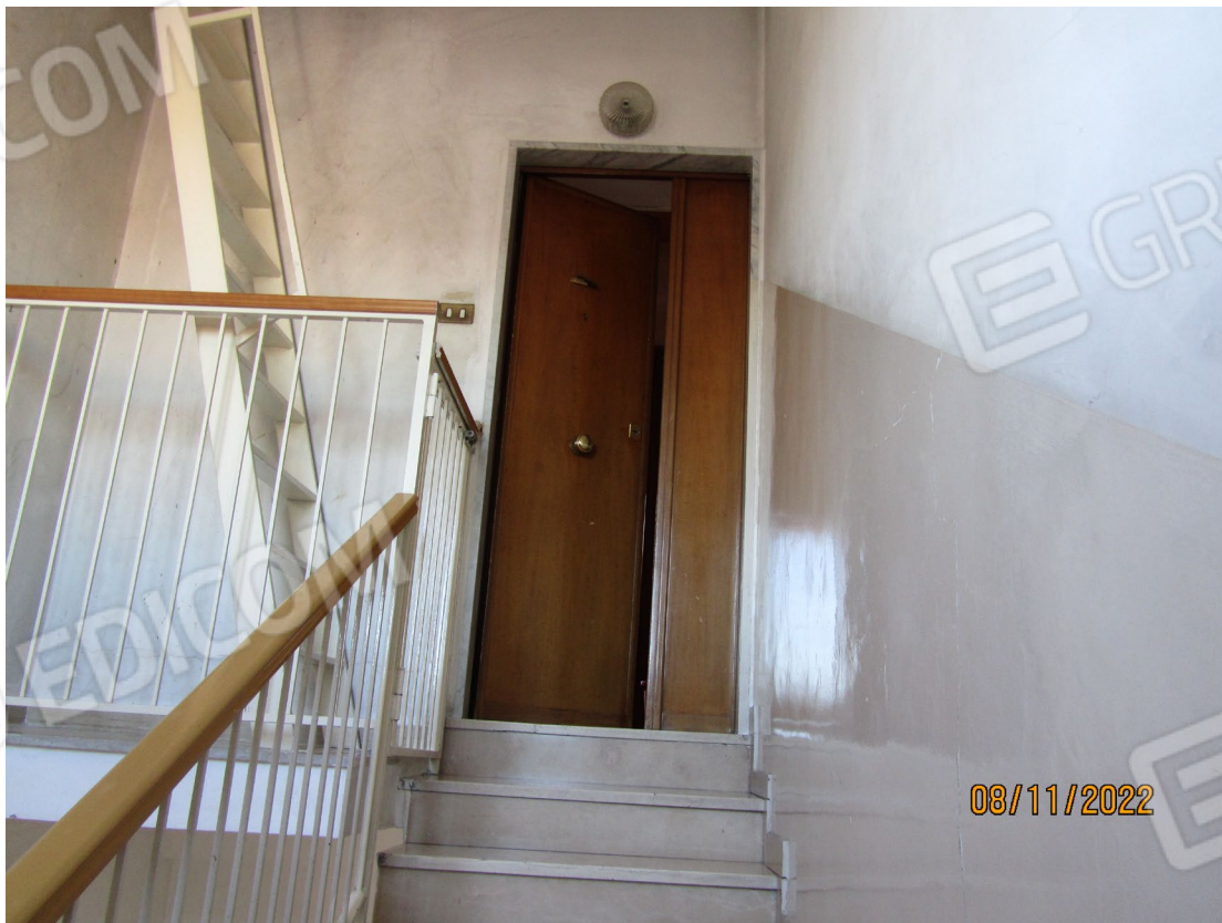
FOTO N.2 – Porta d'ingresso al 4° piano.
