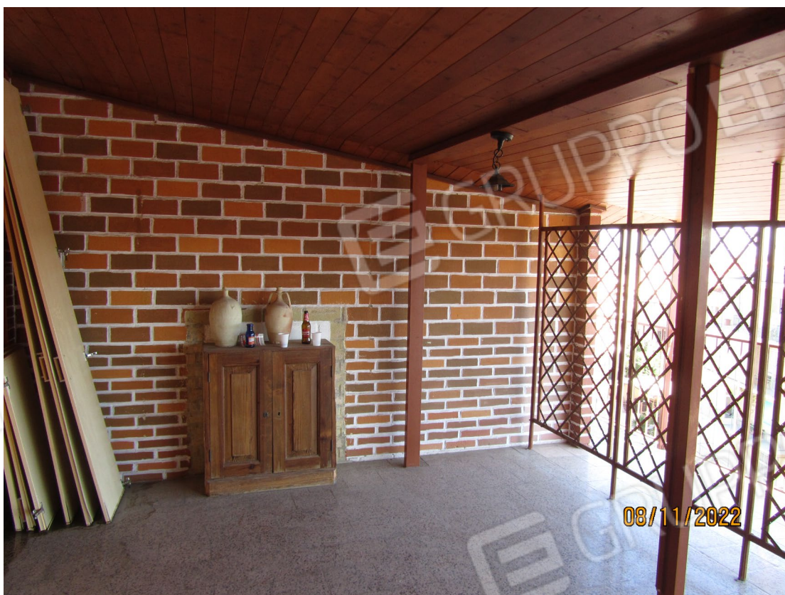
FOTO N.13 – Terrazzo esterno, porzione nord-est.
