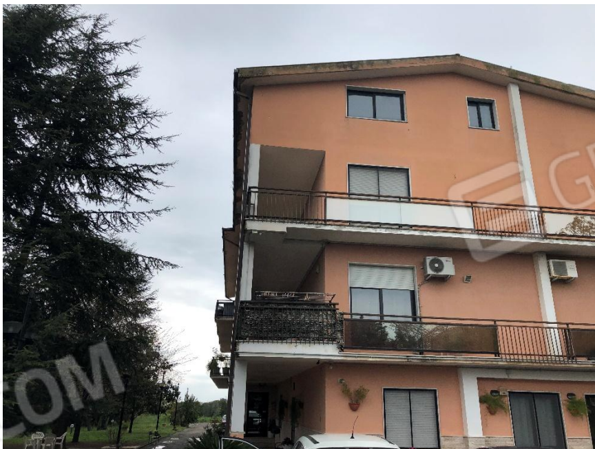
Foto n. 2: Facciata ingresso fabbricato - appartamento oggetto di stima piano terra
