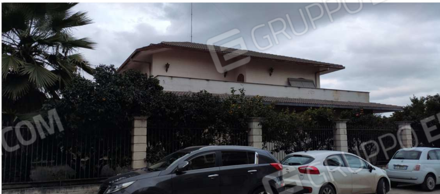
Prospetto dell'immobile lungo via Piersanti Mattarella
