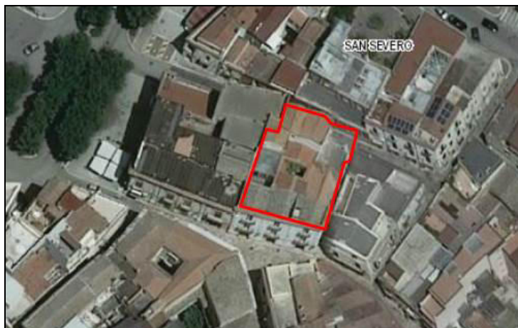
Figura 2. Fotografia aero-planimetrica del fabbricato in cui è inserito il bene.
