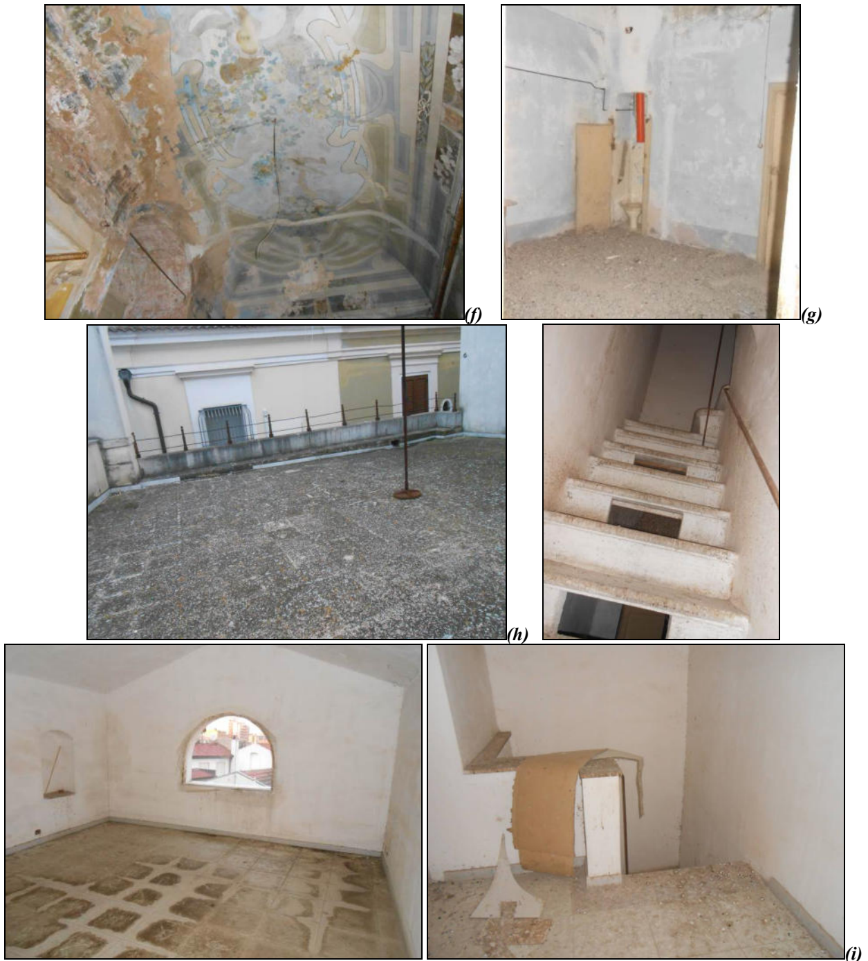
Figura n° 8. Fotografie della porzione di appartamento in primo e secondo piano: porta di accesso in legno (a); ingresso (b); stanze in primo piano (c); caminetto (d); dettagli delle pavimentazioni in ceramica pregiata (e); volte e pareti con segni di degrado e danneggiamenti (f); bagno a primo piano (g); terrazzo a livello (h); scalinata di accesso e soffitta in secondo piano (i).
