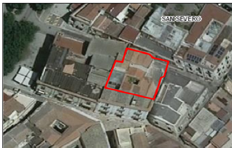
Figura 4. Fotografia aero-planimetrica della porzione di fabbricato in cui è inserito il bene pignorato.
