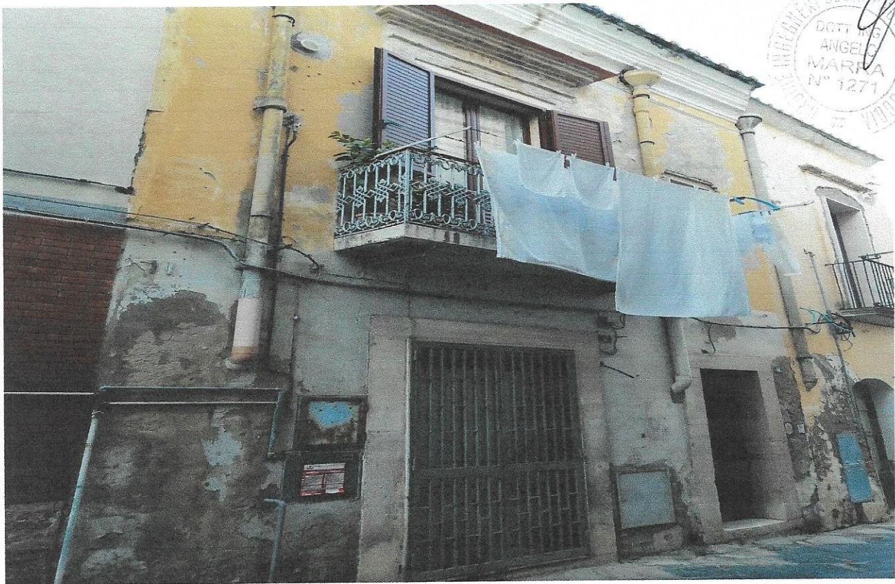
1 – Part. prospetto principale abitazione via Dell'Olmo
