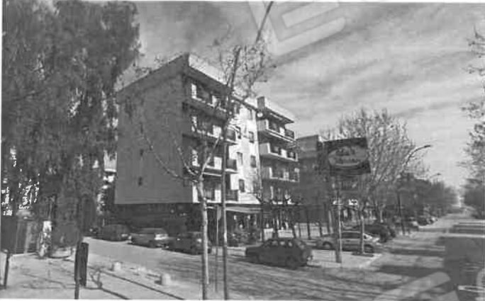
Foto n°1 Fabbricato in angolo tra strada privata (sinistra) e via delle Repubblica (destra)
