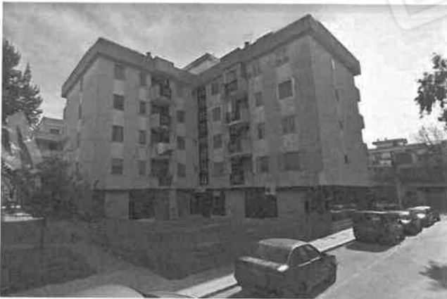
Foto n°1 Il portone di accesso in angolo tra le due ali dell'edificio
