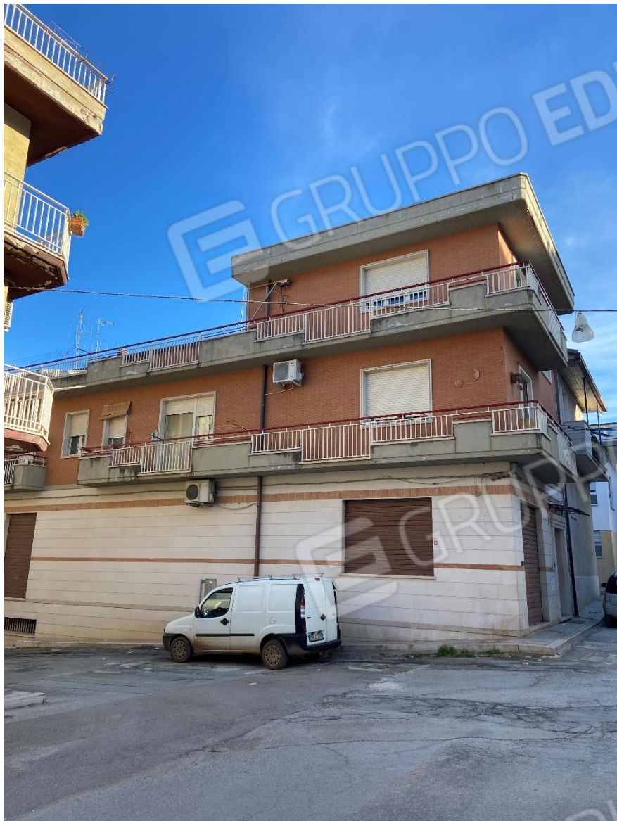
Foto 2) – Vista edificio da via dei Fenici IMMOBILE A-B-C-D
