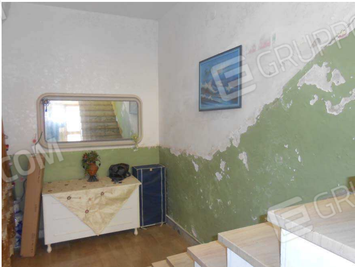
Foto 4. Il vano scala comune (piano terra).
