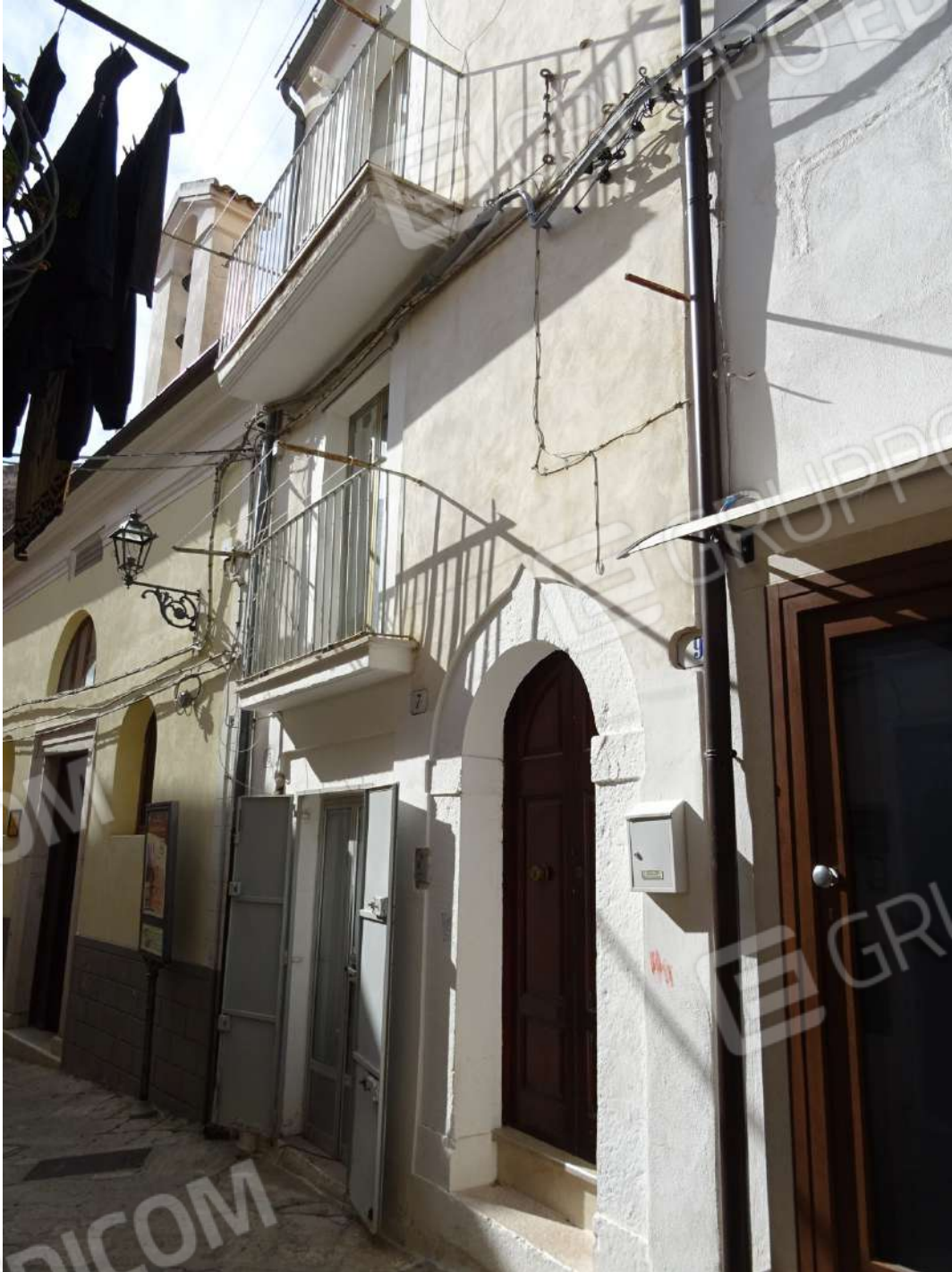
Foto quarto sopralluogo del 07.02.2024
