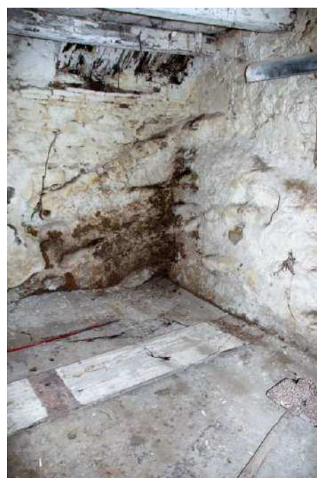
Vista interna immobile civ.13
