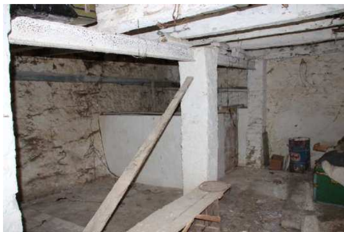
Vista interna immobile civ.13
