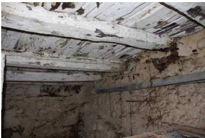
Vista interna immobile civ.13
