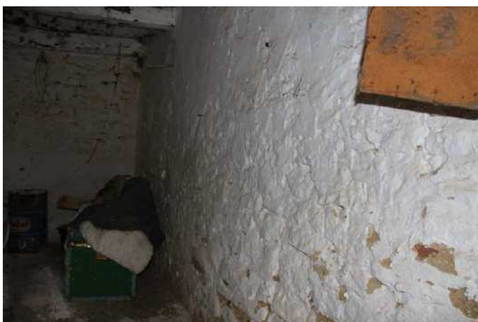
Vista interna immobile civ.13
