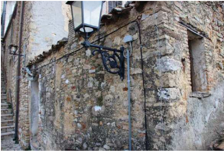
Vista esterna fabbricato
