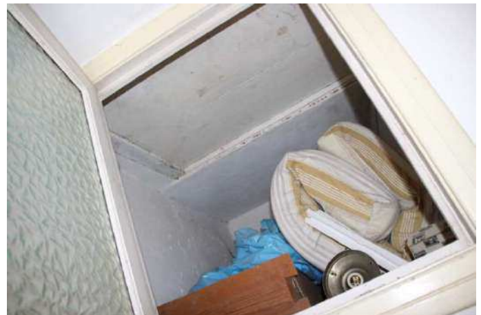
Vista vano ripostiglio sopra w.c.
