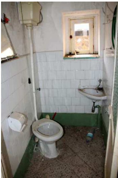
Vista w.c piano primo
