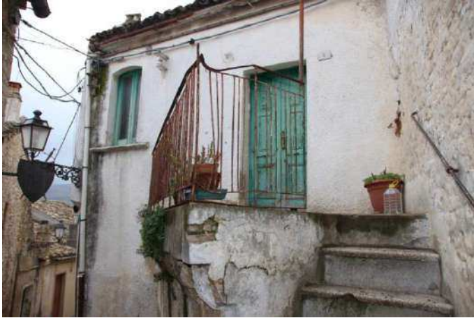
Vista esterna piano primo ingresso civ. 8
