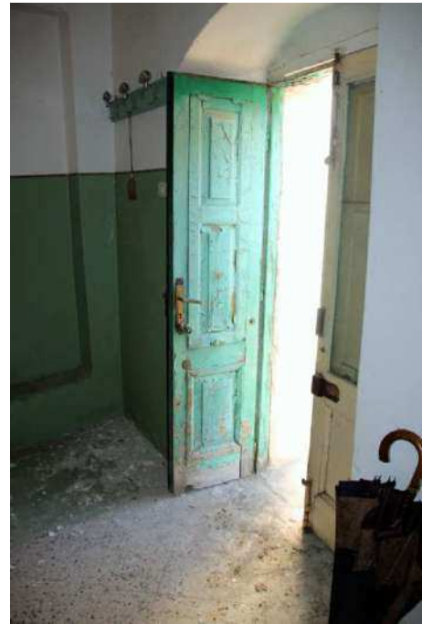
Vista interna ingresso piano primo civ. 8
