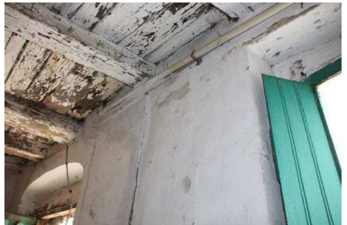
Vista copertura locale piano terrea
