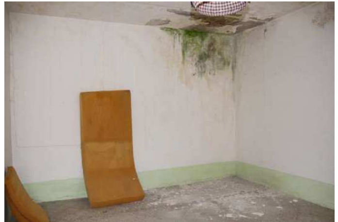
Vista locale piano primo
