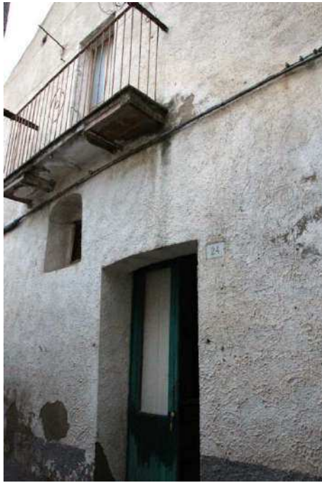
Vista esterna ingresso Via Antonelli 24-
