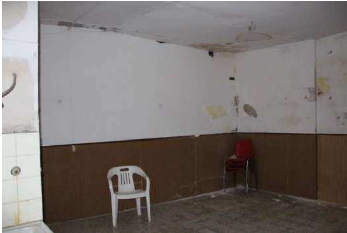
Vista primo vano piano terra
