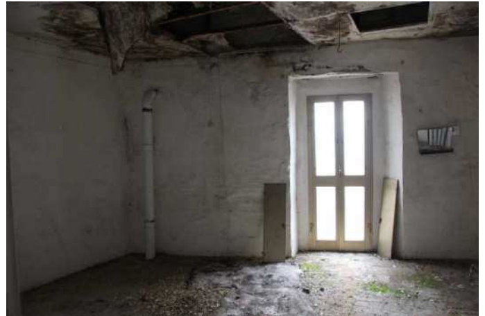
Vista camera piano primo
