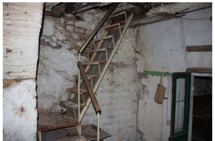
Vista vano interno e scalinata in ferro
