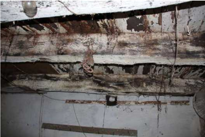
Vista travi in legno
