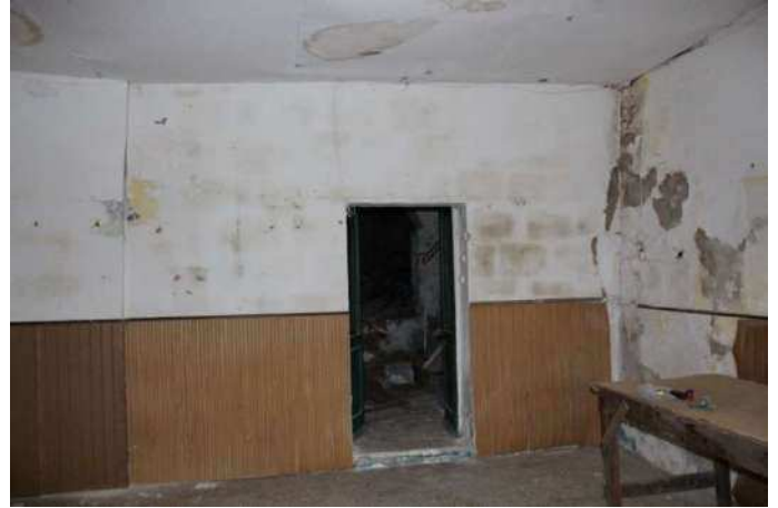
Vista primo vano piano terra-
