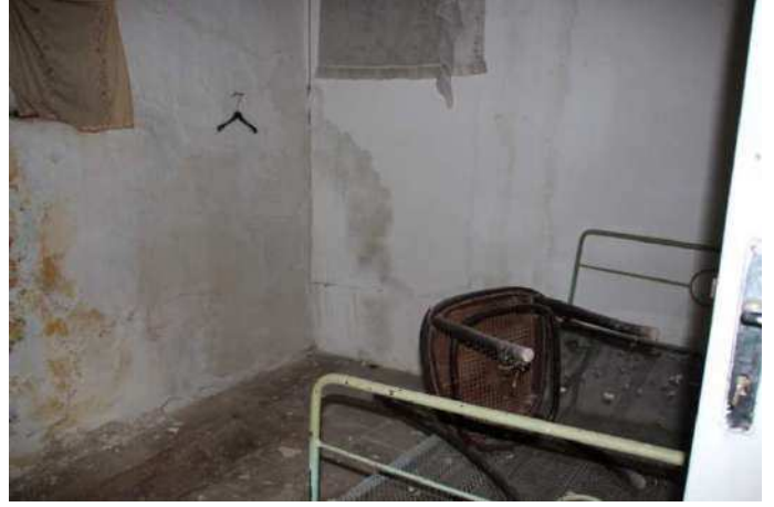
Vista interna camera piano primo
