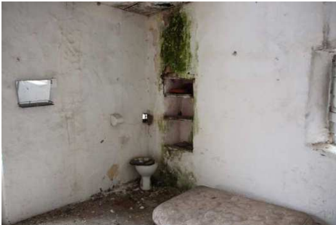
Vista camera piano primo con servizio igienico
