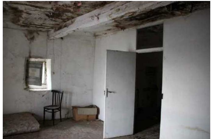
Vista camera piano primo
