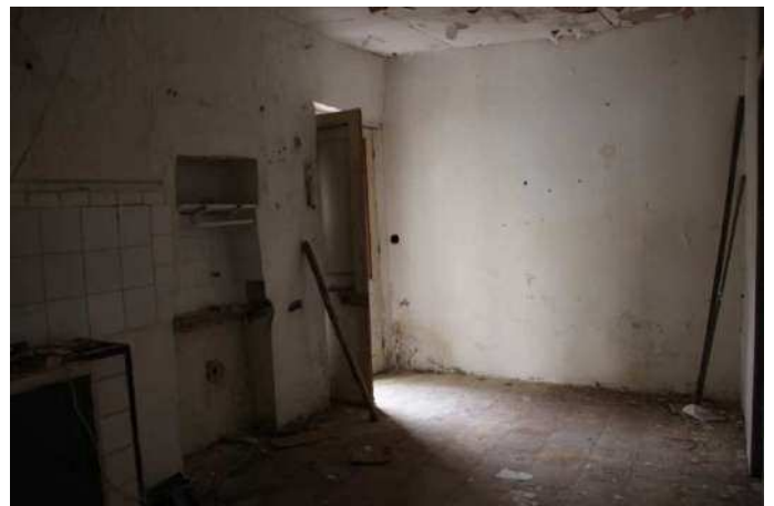
Vista camera con ingresso da Vico Clemente
