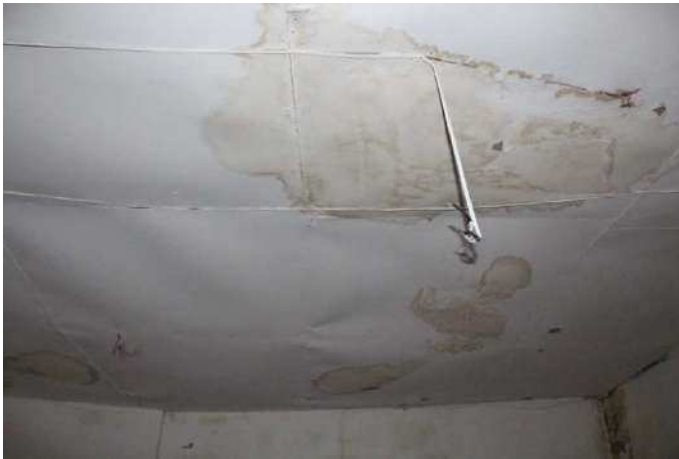
Vista soffitto primo vano piano terra
