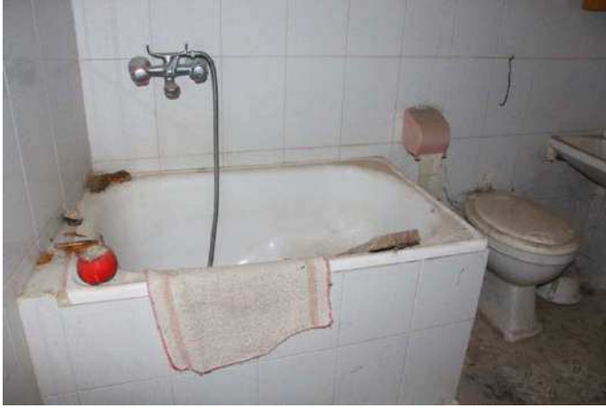
Vista interna w.c.
