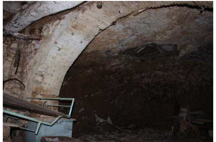
Vista vano interno piano terra
