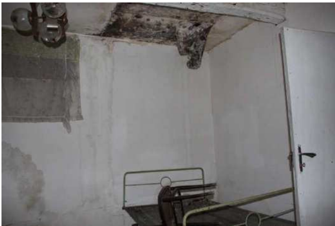
Vista interna camera piano primo
