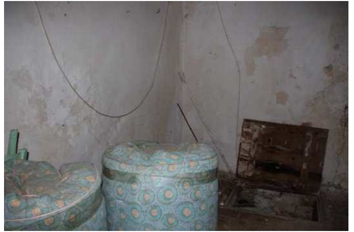
Vista botola accesso al piano terra
