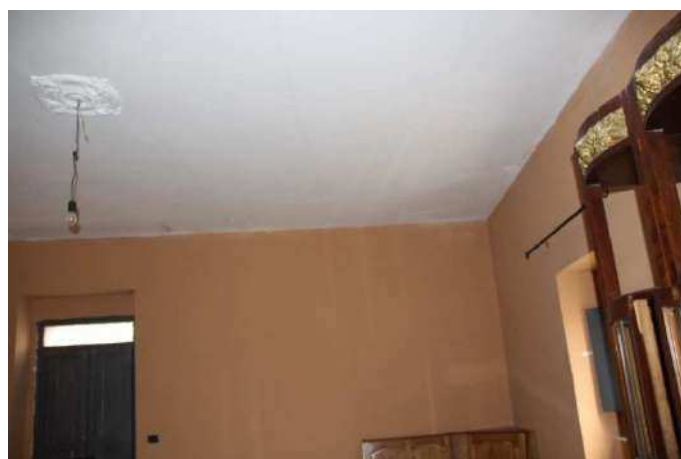
Vista piano primo (civ. 8) immobile
