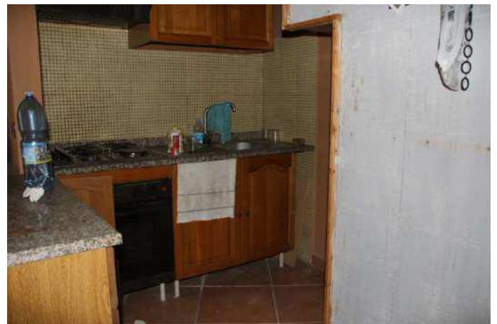
Vista angolo cucina vano piano terra (civ. 10)
