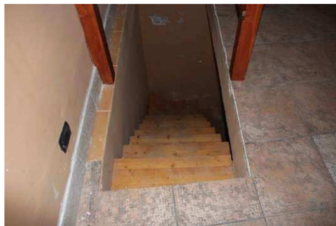
Vista della scalinata interna in legno di accesso al 1° piano
