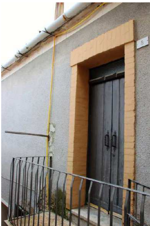
Vista esterna immobile civ. 8-
