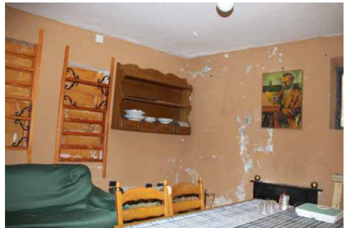
Vista vano piano terra (civ. 10) immobile
