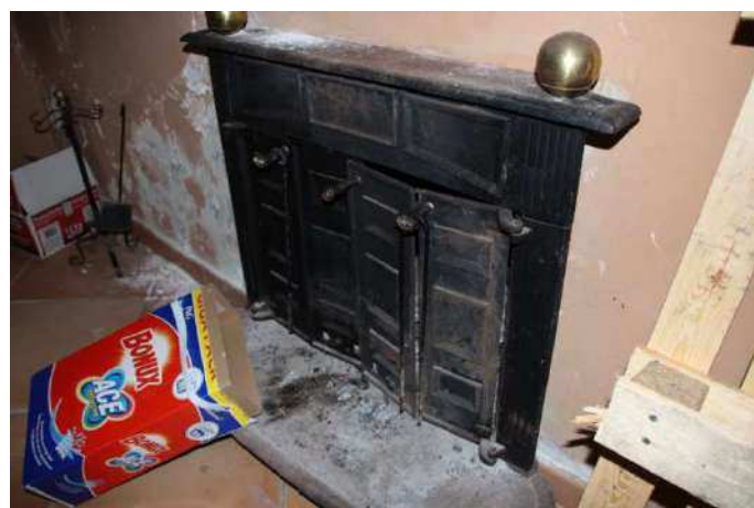
Vista camino piano terra (civ. 10) immobile
