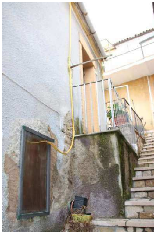
Vista esterna immobile civ. 8
