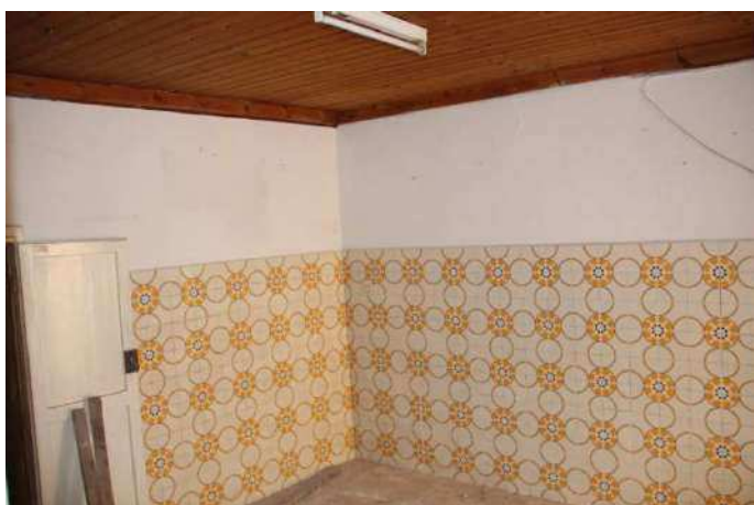
Vista vano principale piano terra immobile -
