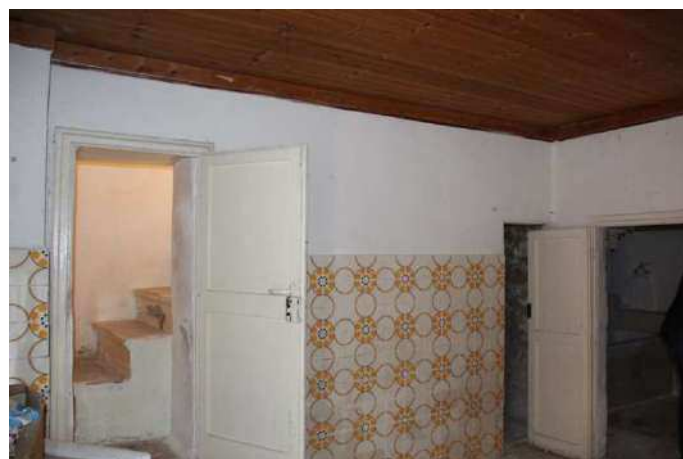
Vista vano principale piano terra immobile
