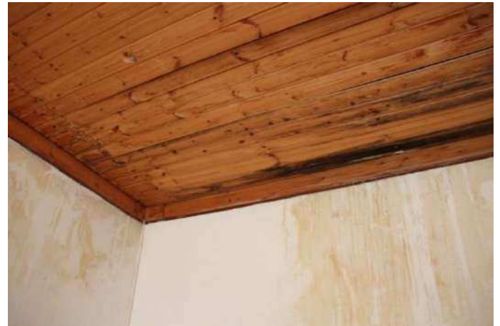
Vista controsoffitto piano primo
