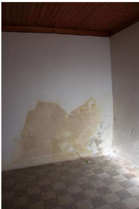
Vista vano primo piano-
