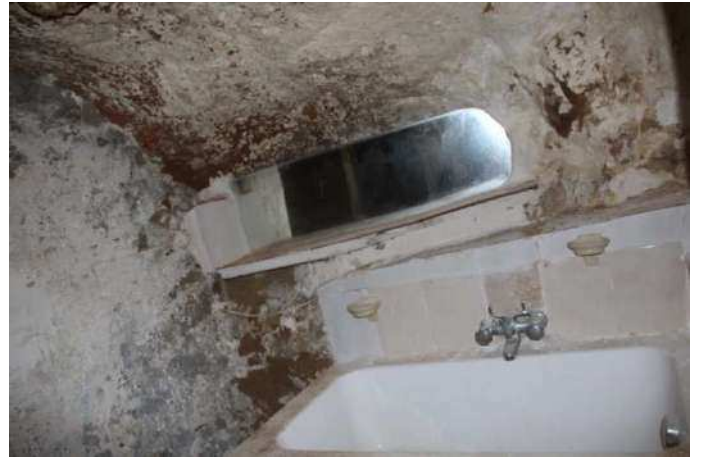
Vista bagno piano terra
