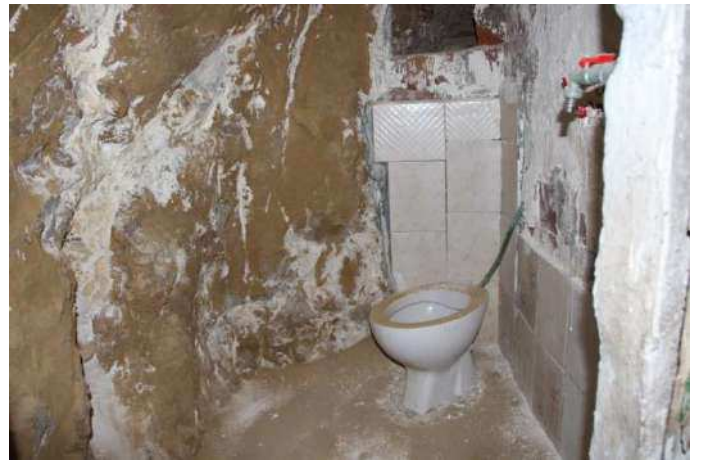
Vista bagno piano terra
