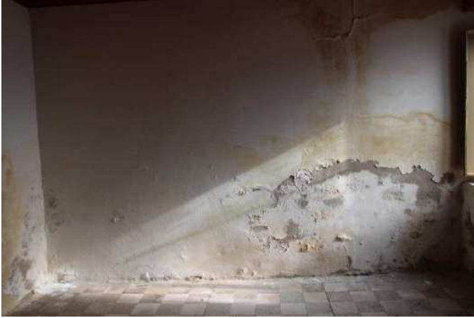
Vista vano piano primo
