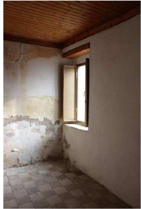
Vista vano piano primo
