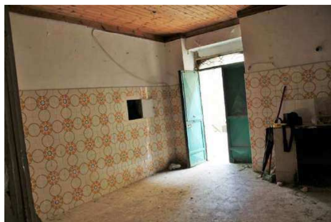
Vista vano principale piano terra immobile
