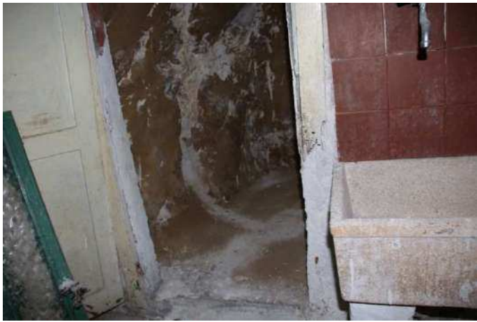
Vista bagno piano terra
