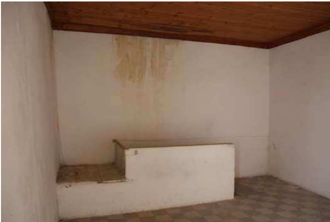
Vista vano piano primo
