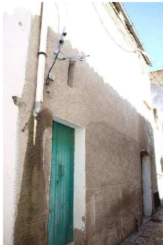
Vista secondo ingresso Via Porta Alta
