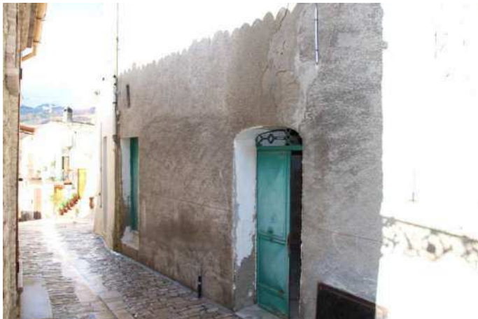
Vista esterna piano terra immobile
