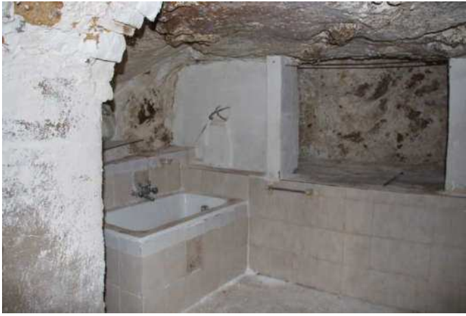
Vista bagno piano terra
