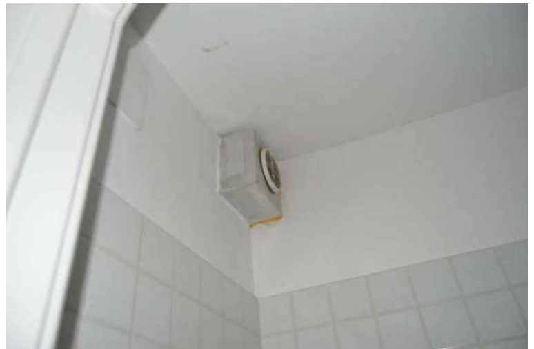
Vista areazione del w.c.
