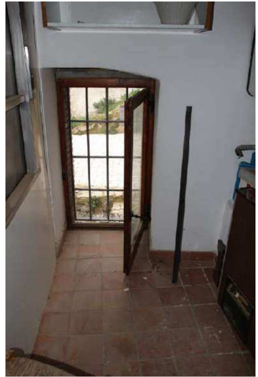
Vista i finestra deposito cucina
