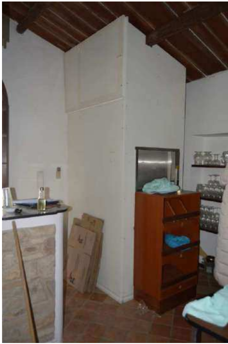
Vista Angolo Bar montacarichi
