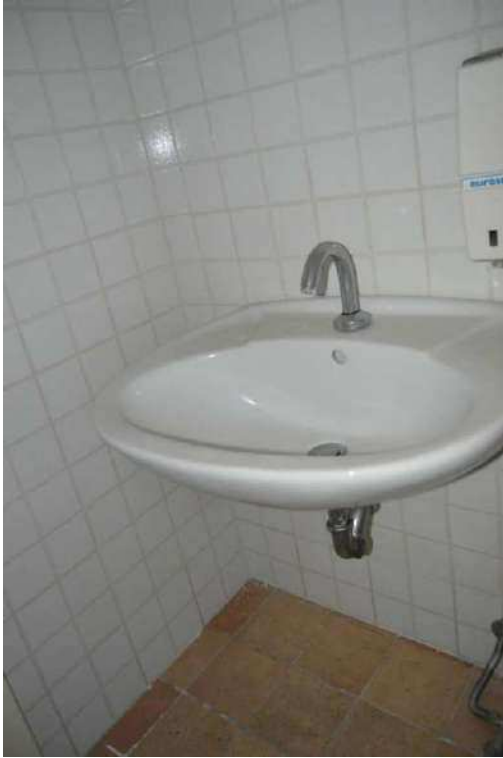
Vista servizi igienici
