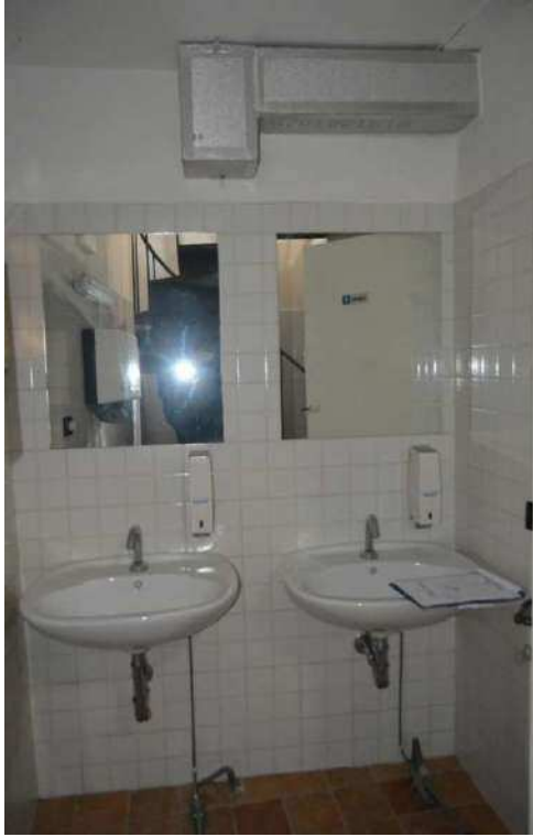
Vista servizi igienici
