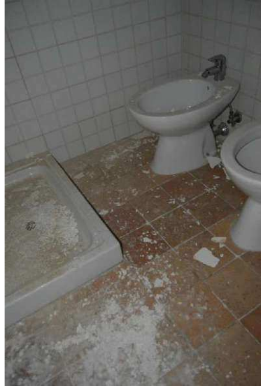
Vista servizi igienici
