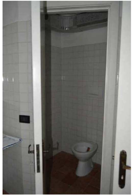
Vista servizi igienici
