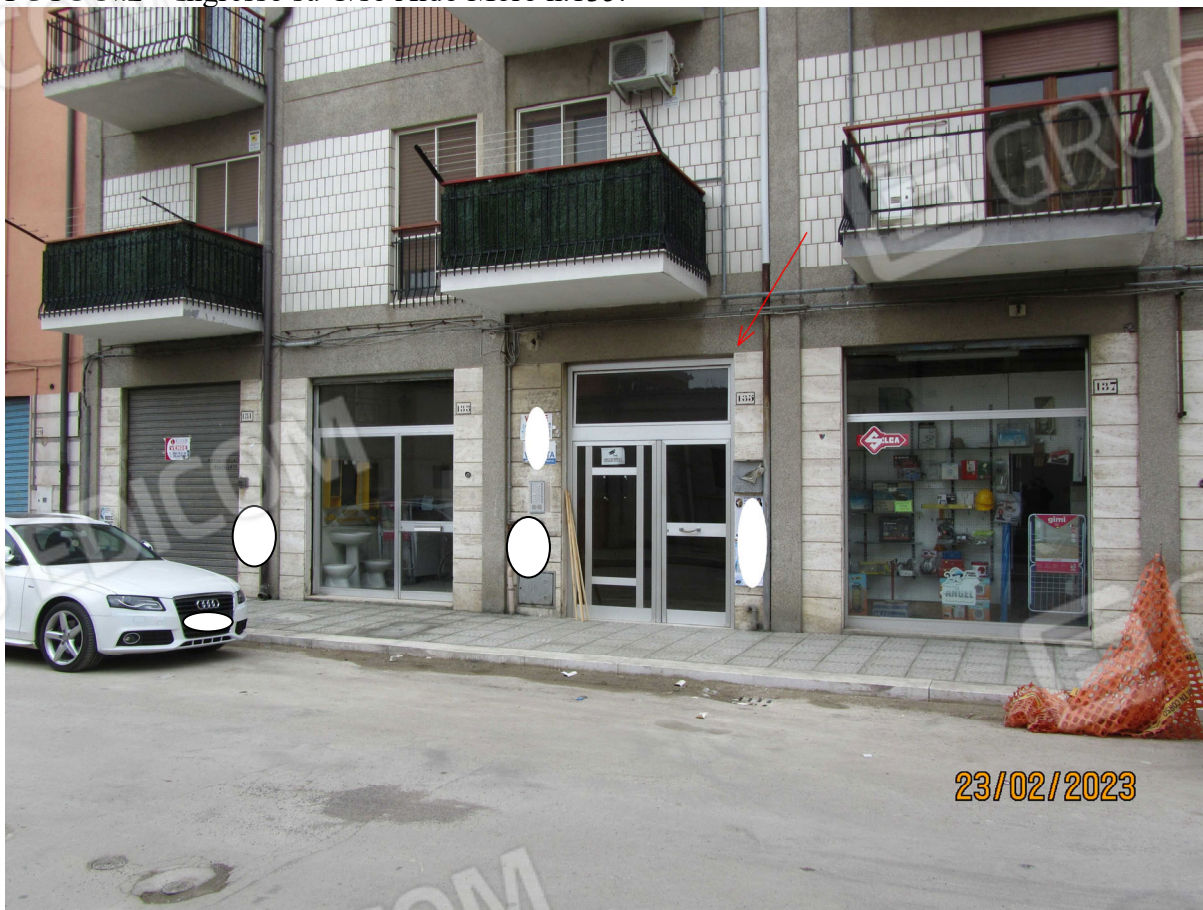
FOTO N.2 – Ingresso su C/so Aldo Moro n.135.
