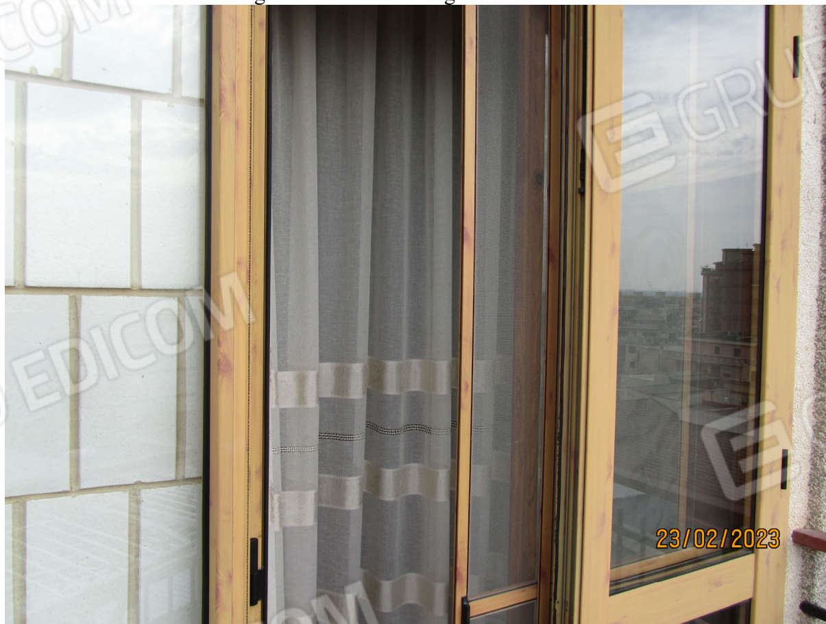
FOTO N.14 – Particolare degli infissi esterni in lega di alluminio.
