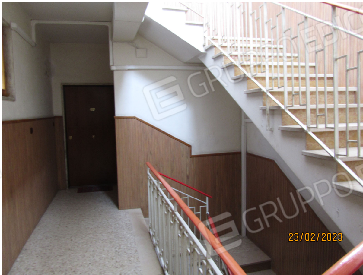
FOTO N.5 – Vista del vano scala condominiale.
