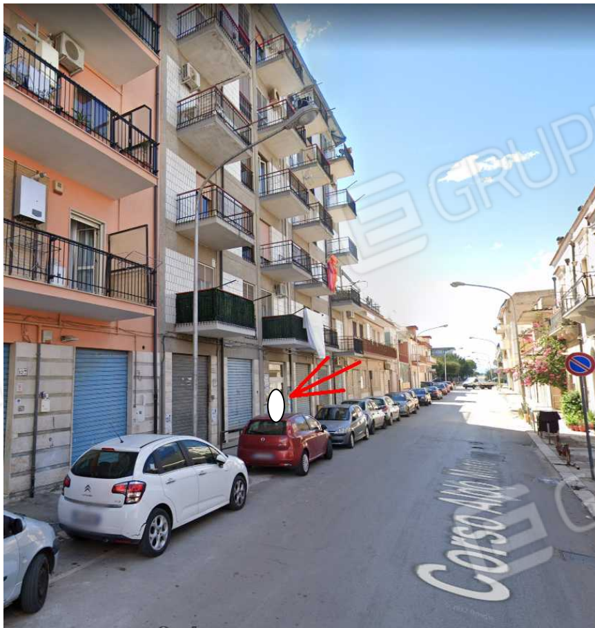
FOTO N.1 – Vista dell'Edificio Condominiale da C/so Aldo Moro.
