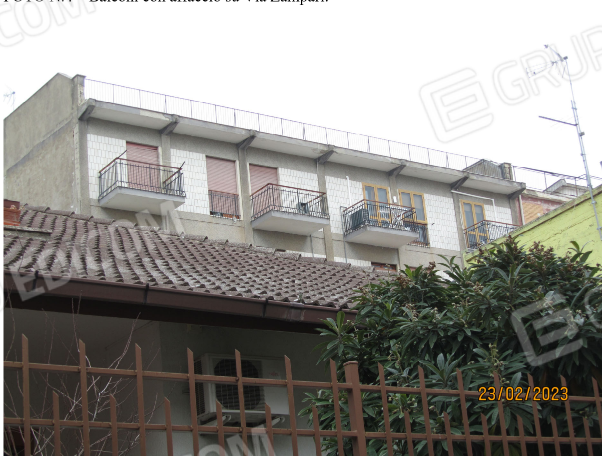
FOTO N.4 – Balconi con affaccio su Via Zampari.
