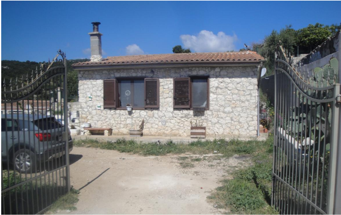
Foto 3: Immobilabile A. Unità abitativa posta in agro di Mattinata, alla Contrada Grasso snc P.T. (in località Coppa Rasa). Prospetto laterale del fabbricato.
