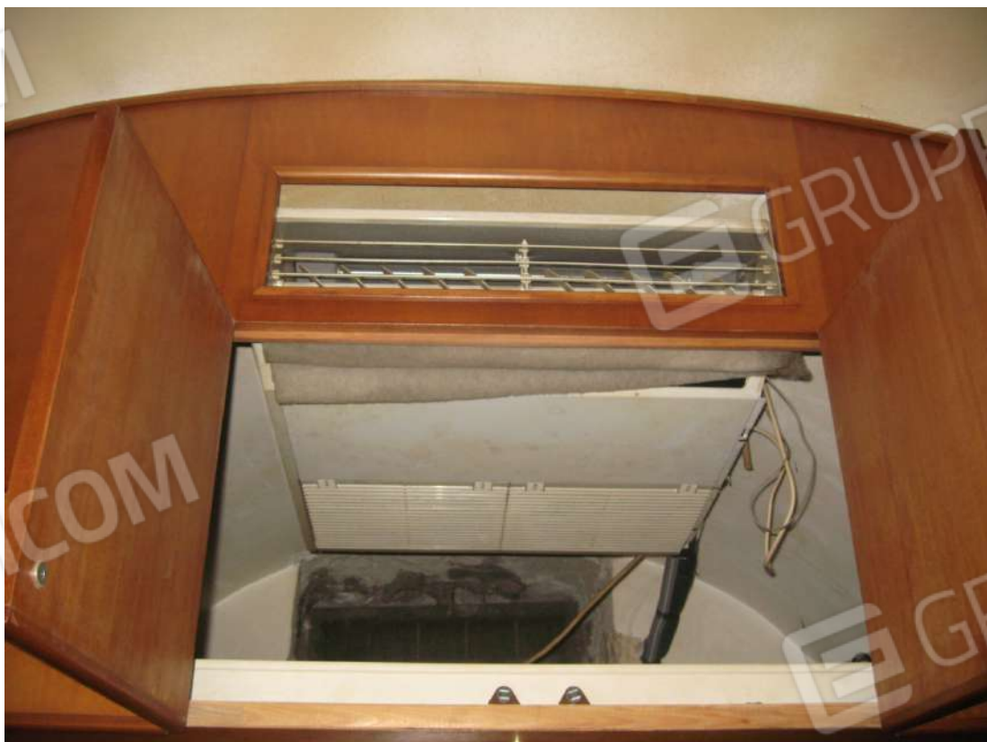
Foto n.18: vista del dell'impianto di condizionamento rivestito da parete in legno e collegato all'esterno sulla retrostante via Sbrasile
