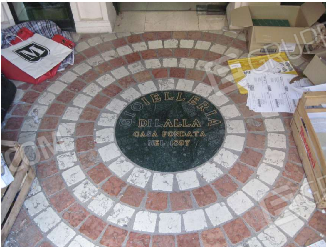
Foto n.6: particolare della pavimentazione nell'atrio d'ingresso al locale commerciale
