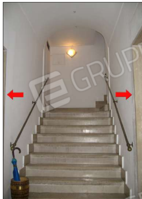
Foto n.9: atrio scale comune con altra proprietà, ubicata al piano superiore; le frecce rosse indicano i due ingressi al lotto 11
