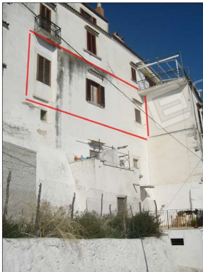
Foto n.19: il contorno rosso identifica il lotto 11, all'interno dello stabile, sul lato prospiciente Via Fontanella
