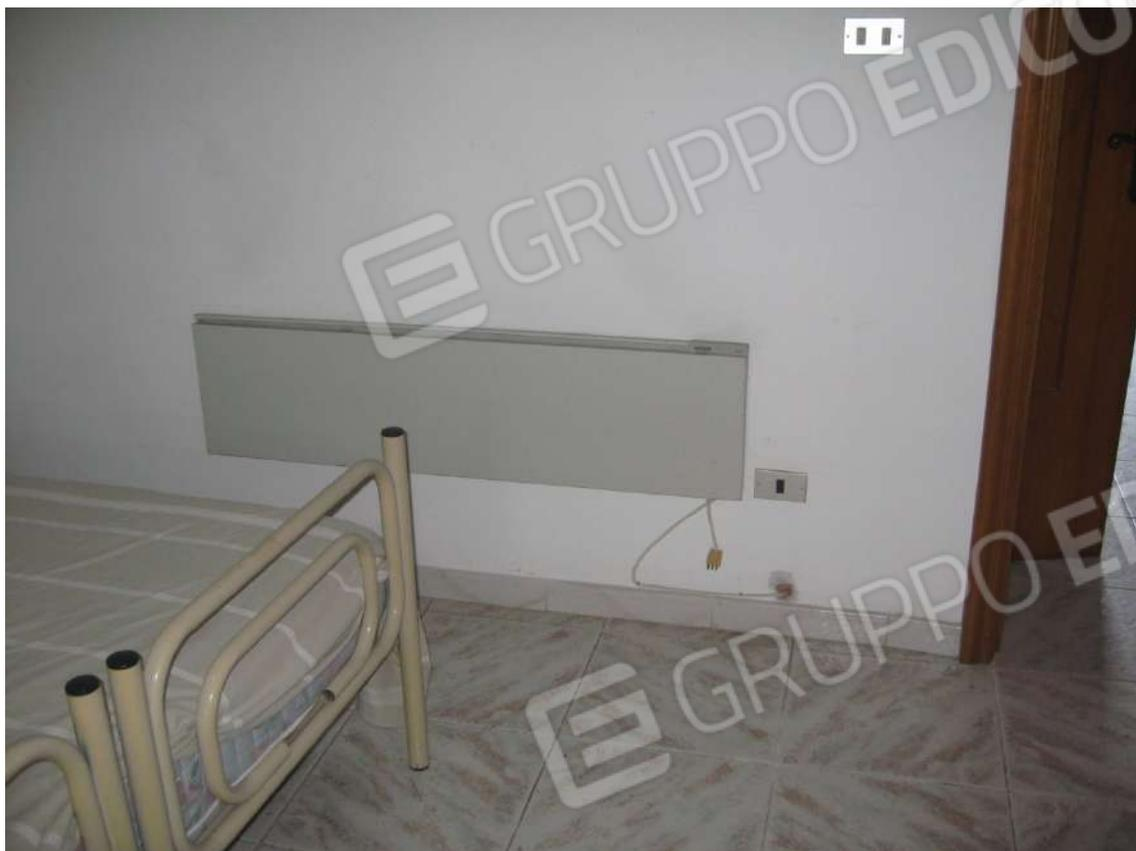
**Foto n.13:** sistema di riscaldamento ad alimentazione elettrica
