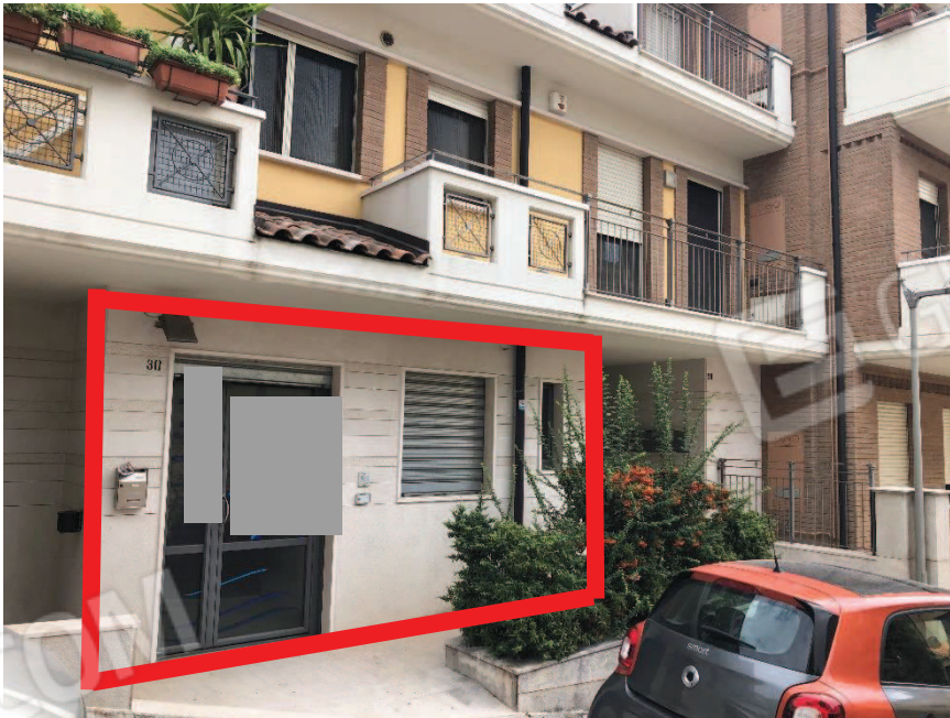
Foto n. 2: Ingresso bene oggetto di stima piano terra – Via Santa Maria di Fatima n. 30
