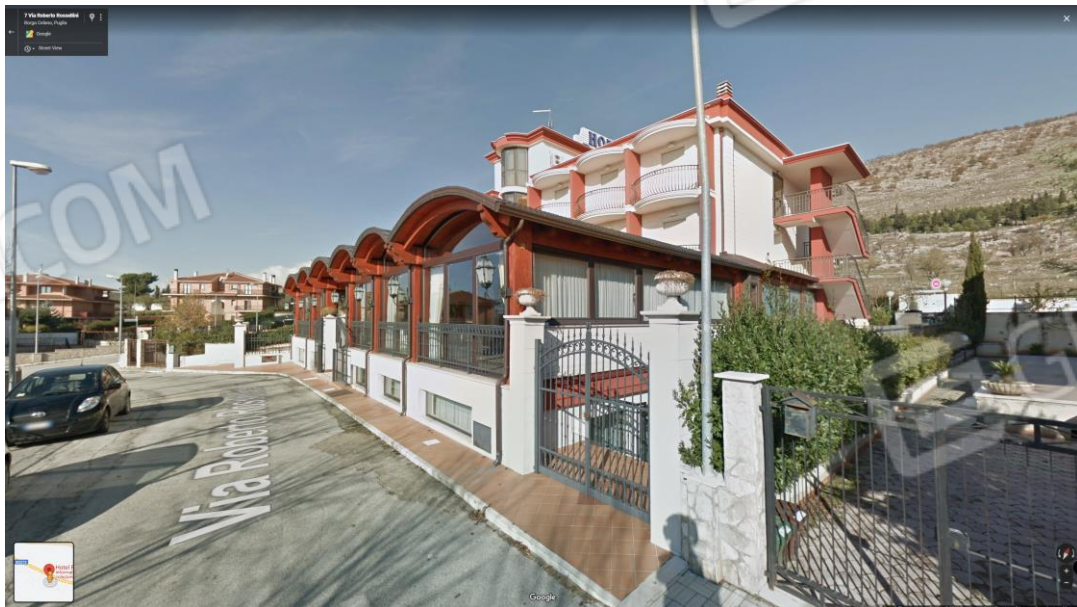
Figura 5: Complesso Hotel Ristorante – prospetto Via Roberto Rossellini, 2
