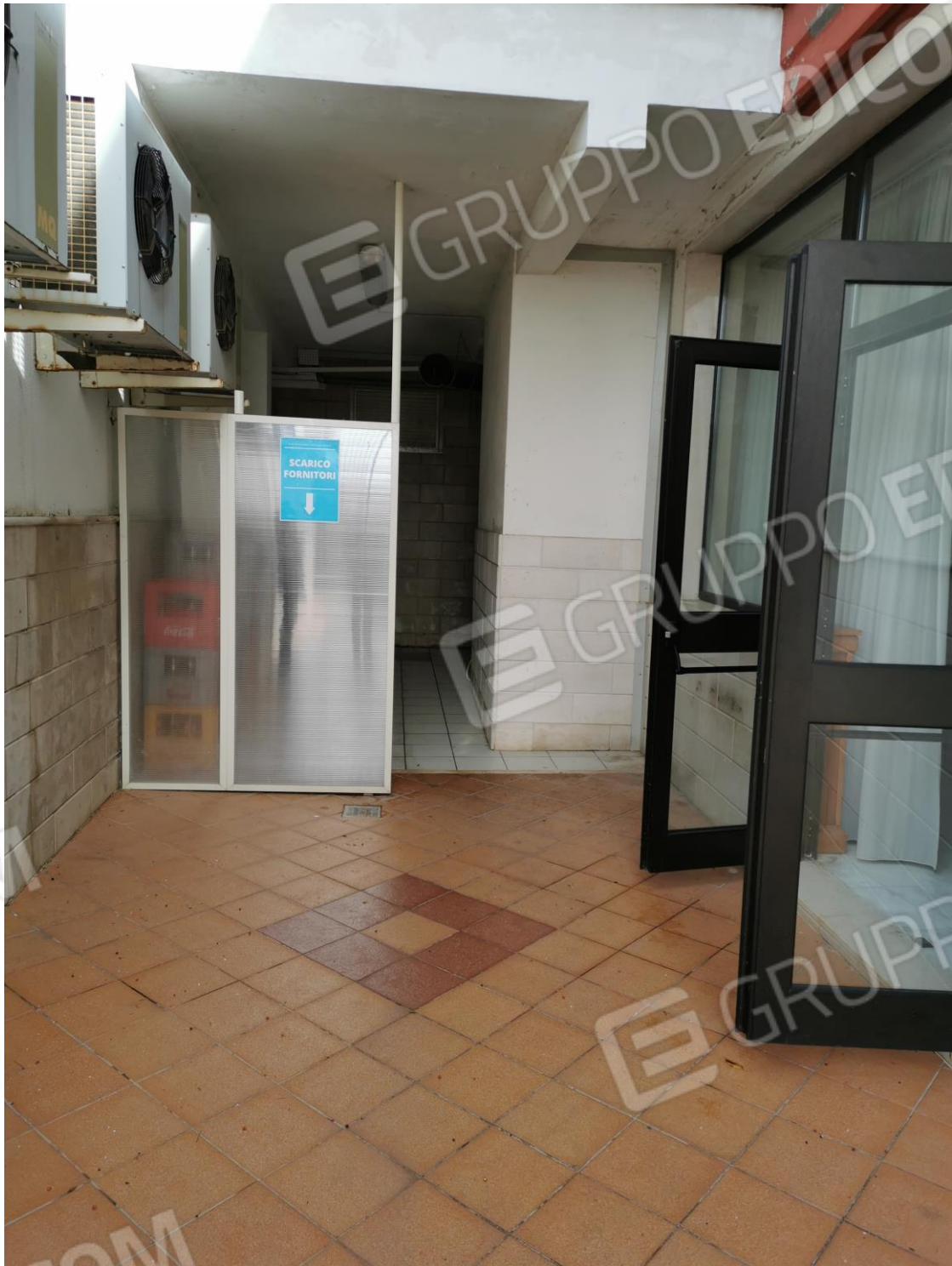
Figura 49: Piano Seminterrato – zona esterna
