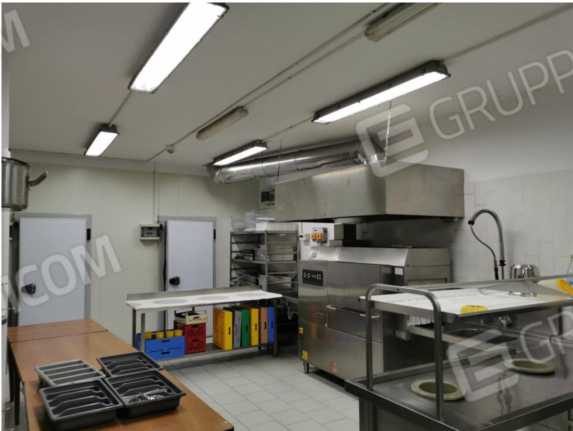
Figura 48: Piano Seminterrato - cucine
