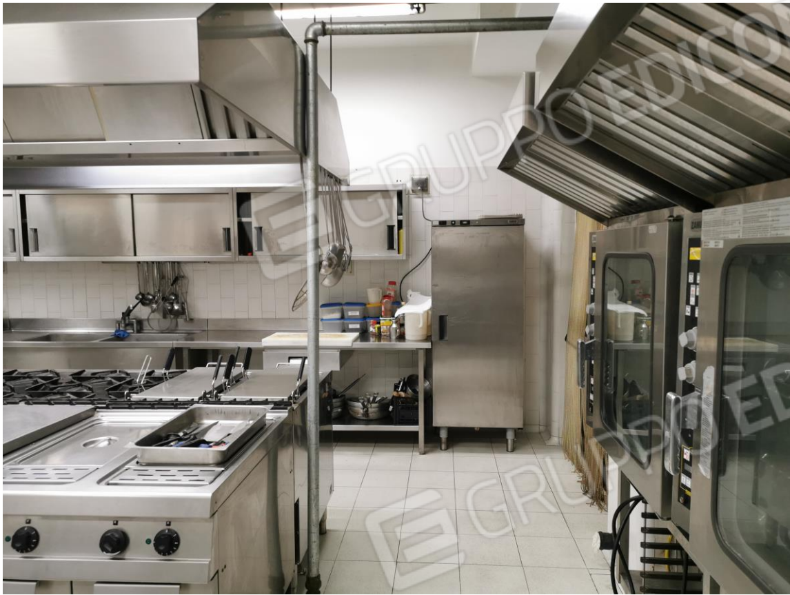
Figura 45: Piano Seminterrato - cucine
