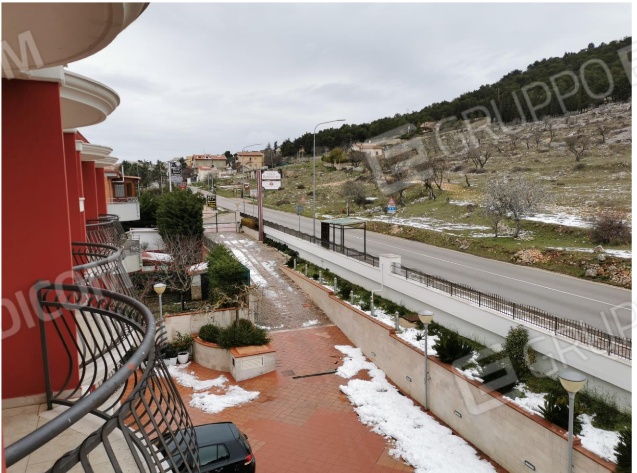
Figura 58: Piano Primo –camere hotel su prospetto retrostante
