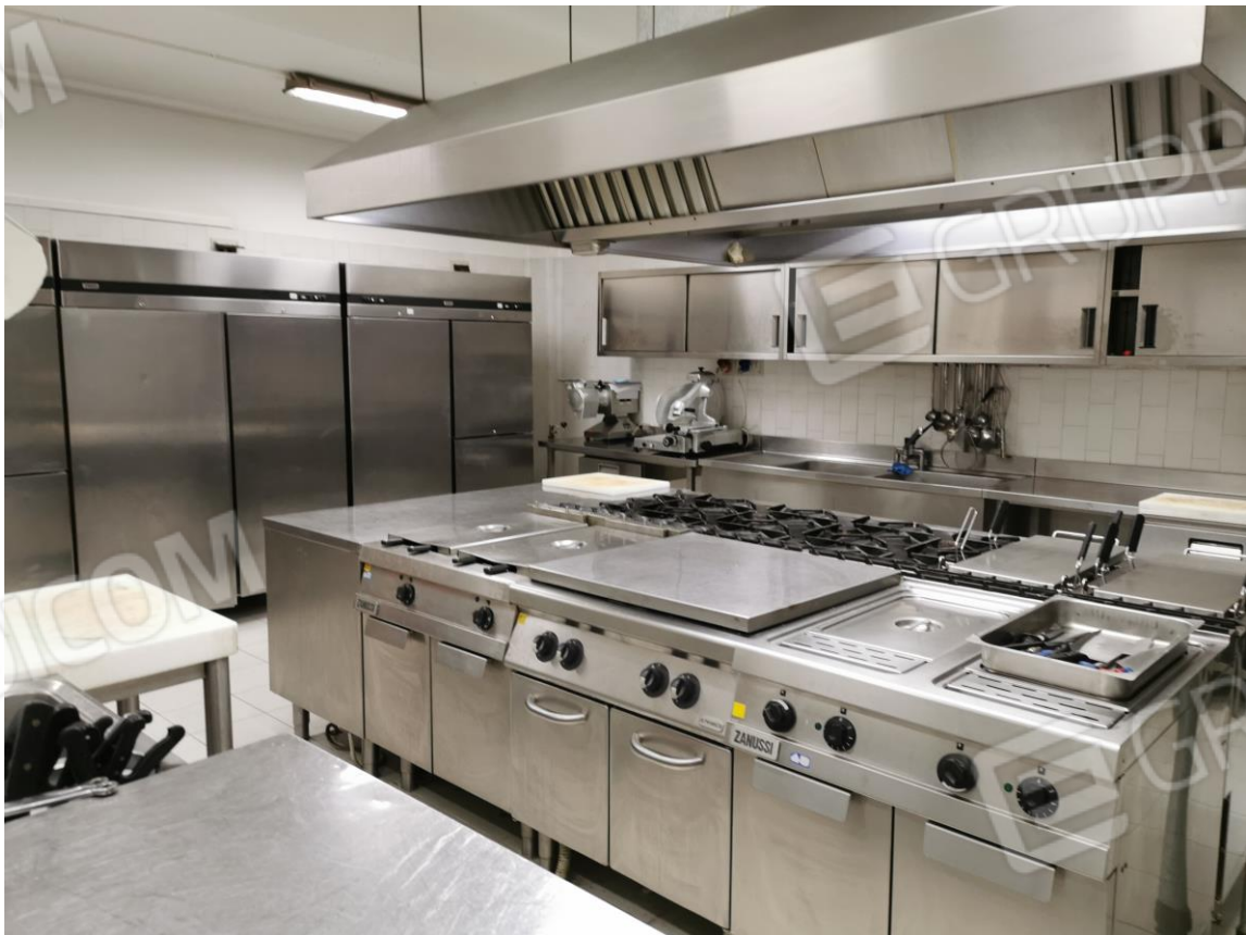
Figura 44: Piano Seminterrato - cucine
