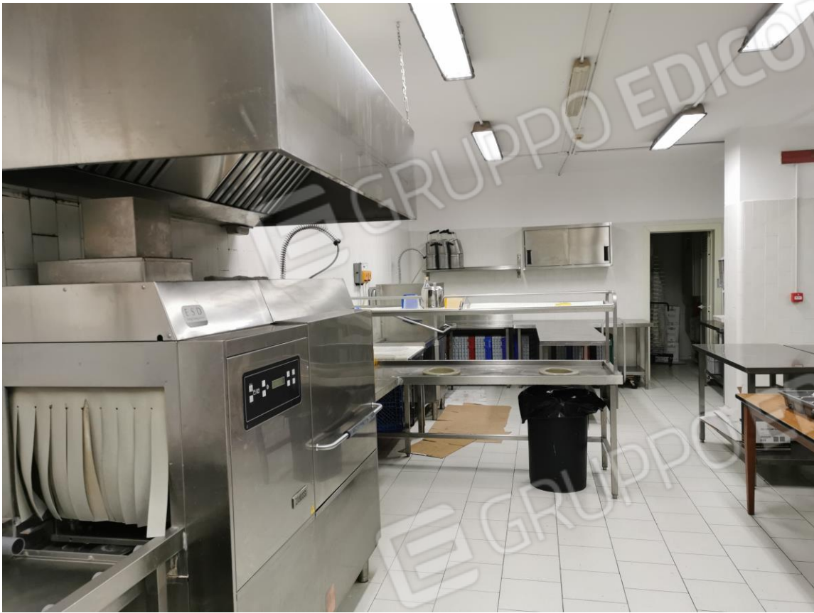
Figura 47: Piano Seminterrato - cucine
