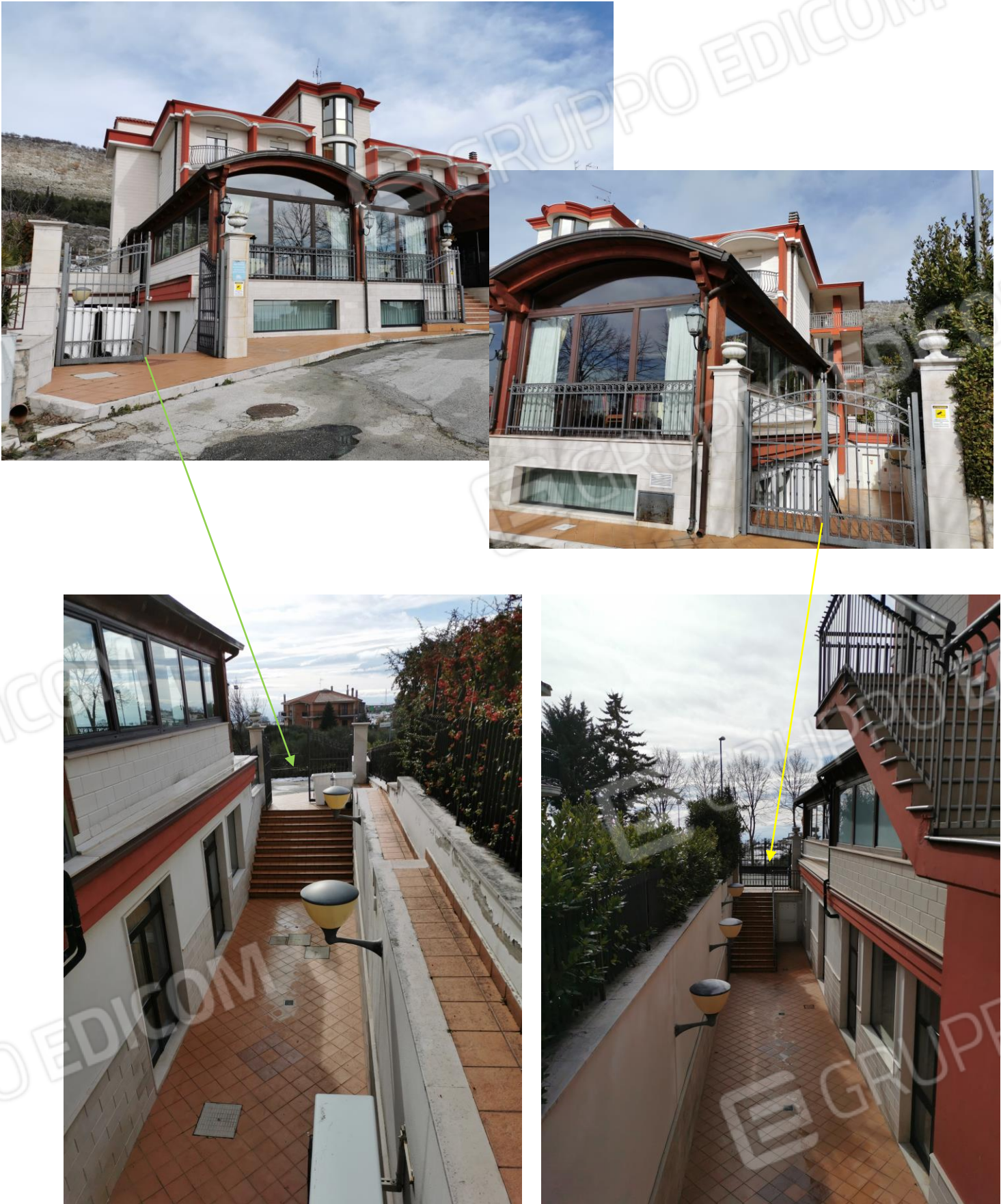
Figura 6: Complesso Hotel Ristorante – prospetto Via Roberto Rossellini, 2
