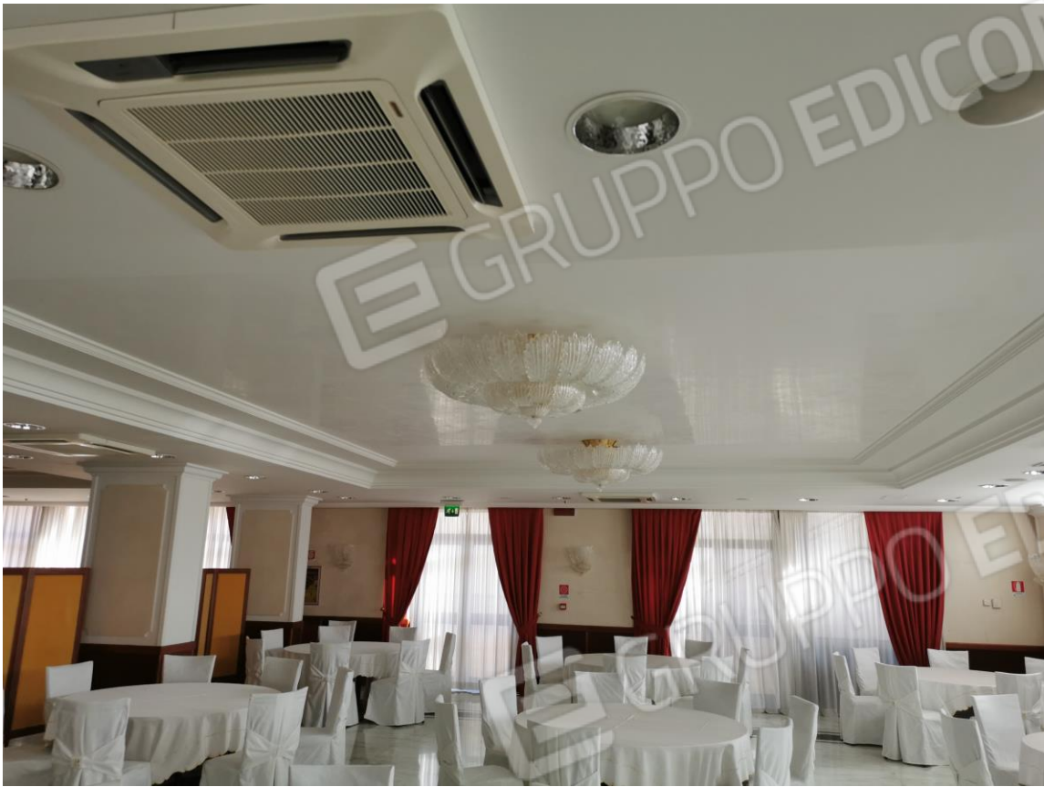
Figura 33: Piano Seminterrato - sala ristorante
