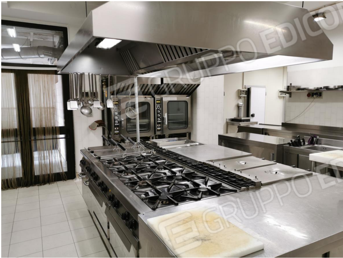
Figura 43: Piano Seminterrato - cucine
