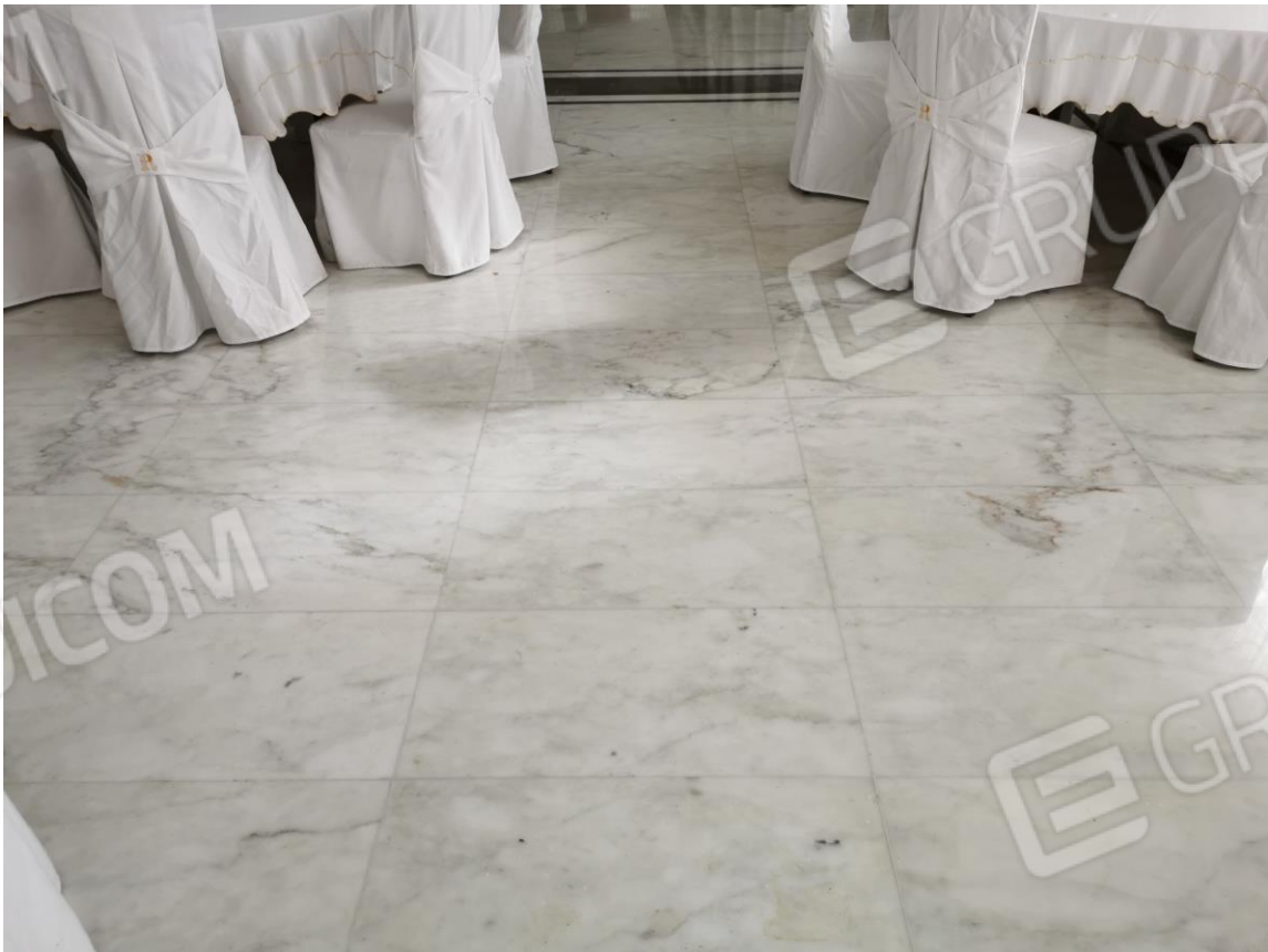
Figura 32: Piano Seminterrato - sala ristorante
