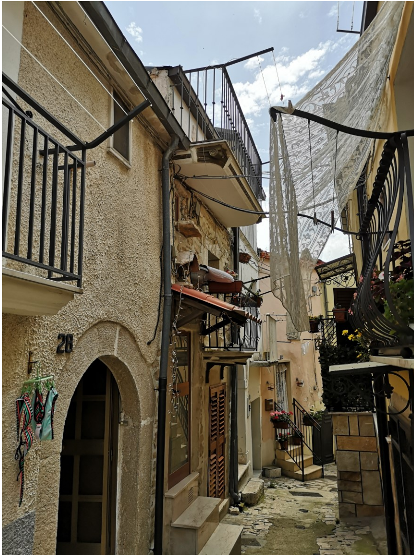
Figura 3 Particolare del balconcino al secondo piano dell'immobile di via Storto Castellana n. 26 (civ. 30 al Catasto)
