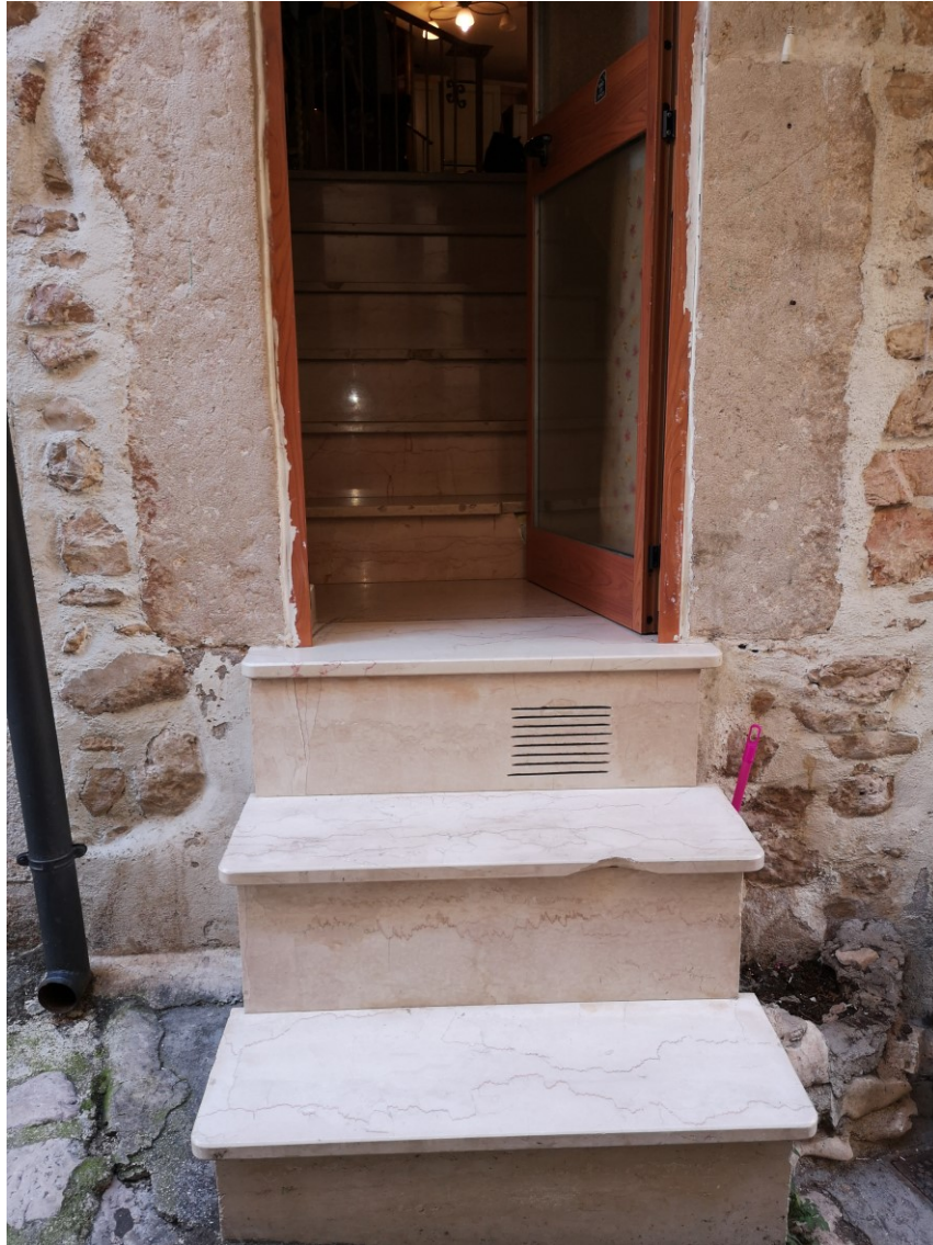
Figura 6 Scale esterne all'ingresso dell'immobile via Storto Castellana n. 26 (civ. 30 al Catasto)
