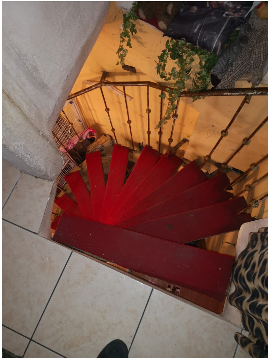
Figura 10 Particolare della scala interna a chiocciola di collegamento tra il piano primo e il piano secondo.
