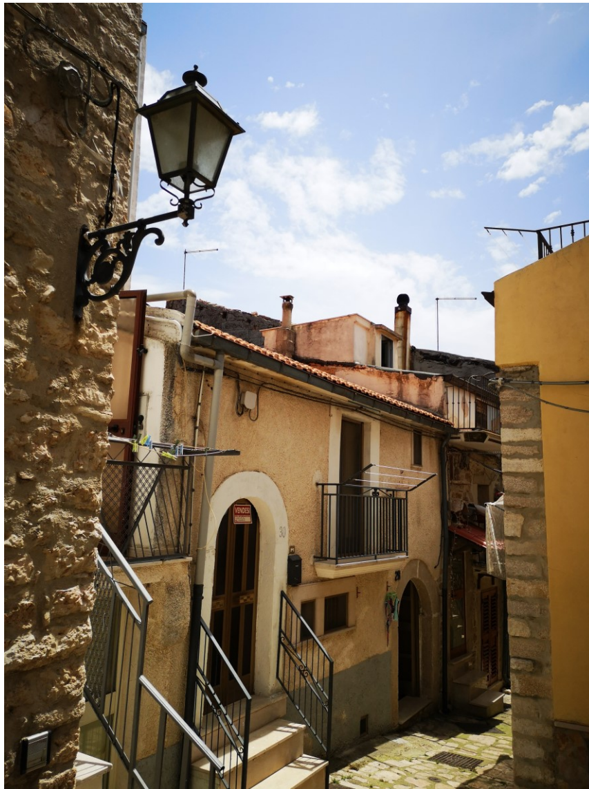
Figura 4 Particolare della copertura del fabbricato di via Storto Castellana n. 26 (civ. 30 al Catasto)
