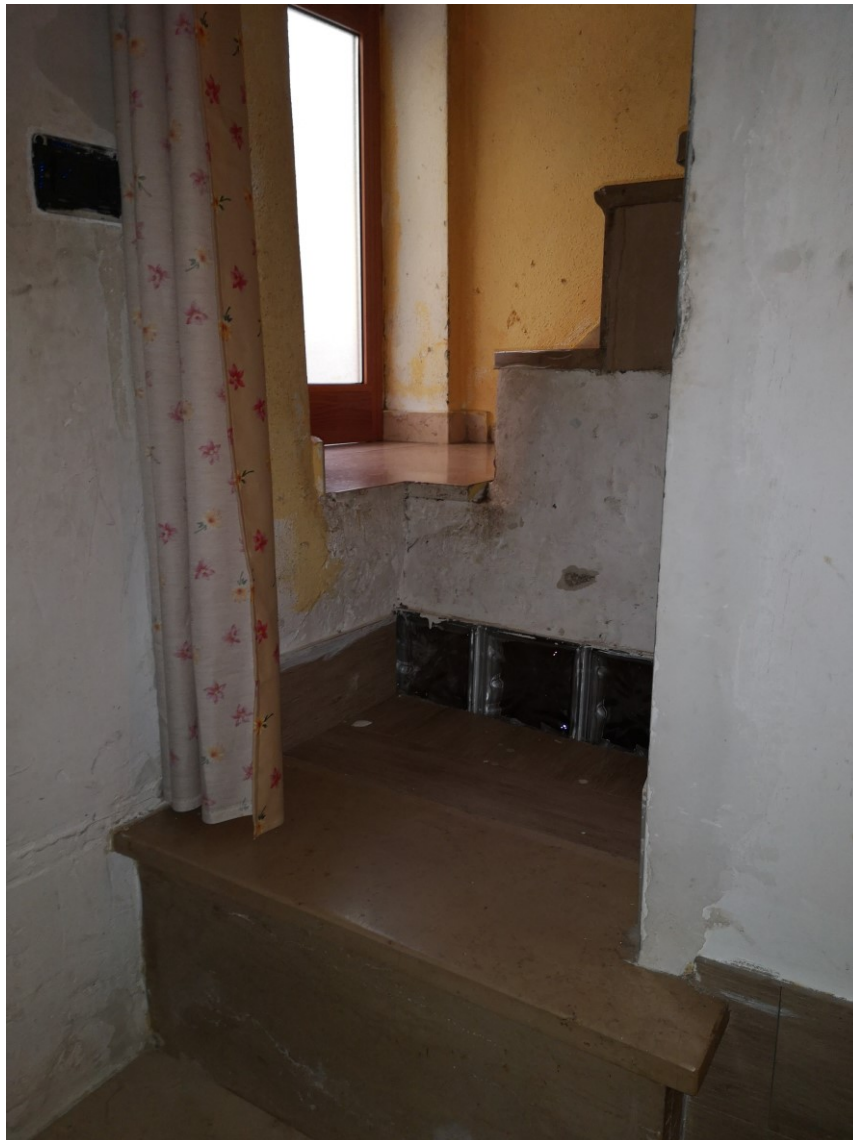
Figura 16 Particolare del passaggio comunicante tra l'immobile ubicato al piano terra in via Storto Castellana civ. 24 (civico 28 al Catasto) e l'immobile posto al piano primo e secondo di Via Storto Castellana civ. 26 (civico 30 al Catasto).
