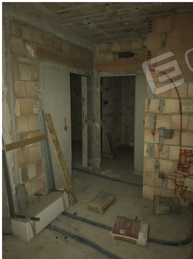
Foto n. 8: vista delle due camere da letto e del ripostiglio
