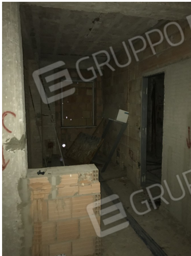
Foto n. 9: vista della cucina e del WC
