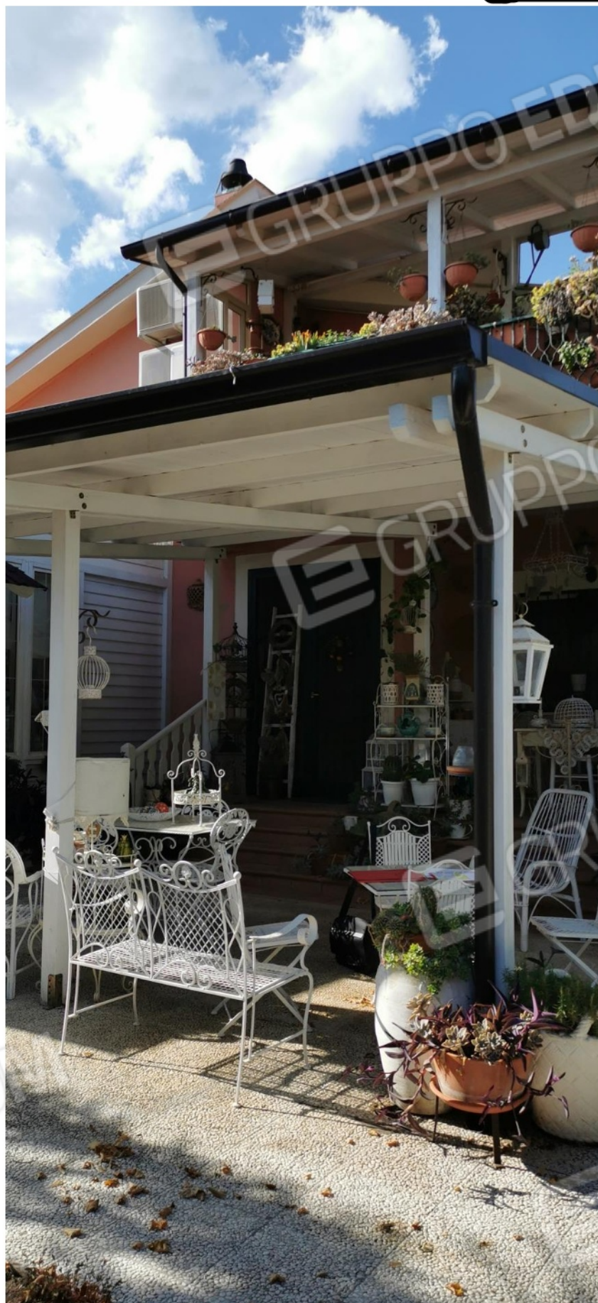
Figura 15: immobile in Lucera (FG) c.da Conocchiola snc (viste esterne)
