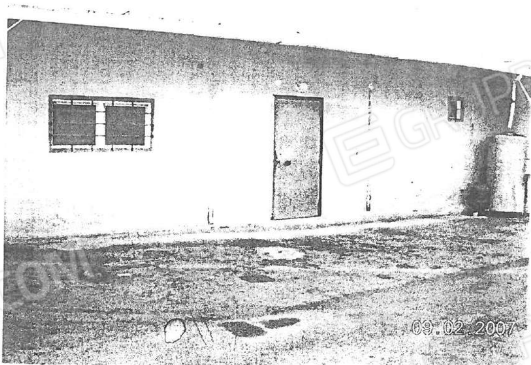
- Beni nn.9 e 10 – 7° Lotto - Vista esterna -
