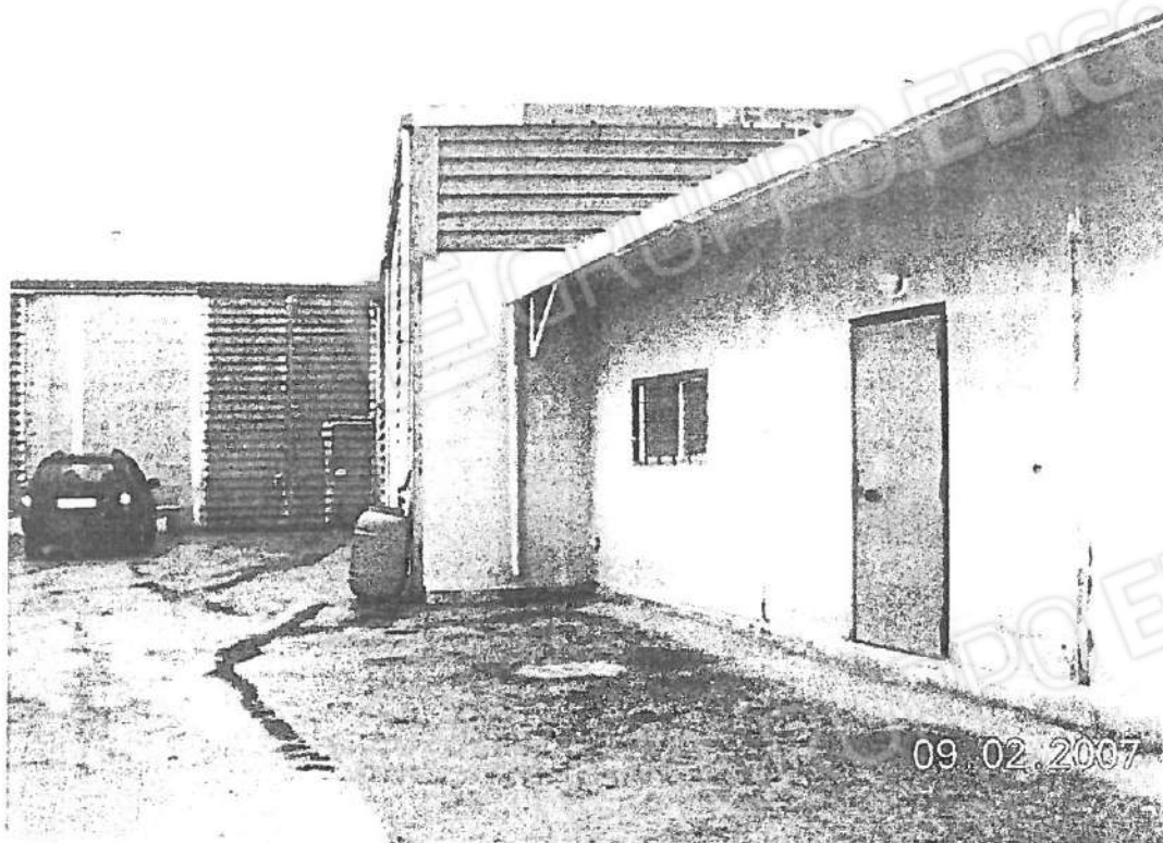
- Beni nn.9 e 10 - 7° Lotto - Vista esterna -
