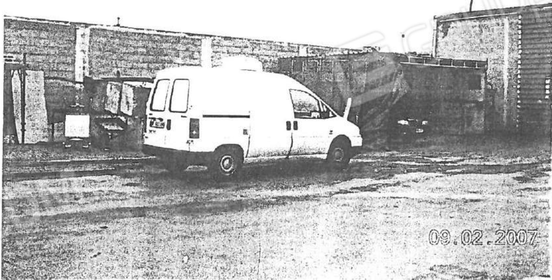
- Beni nn.9 e 10 – 7° Lotto - Vista esterna -
