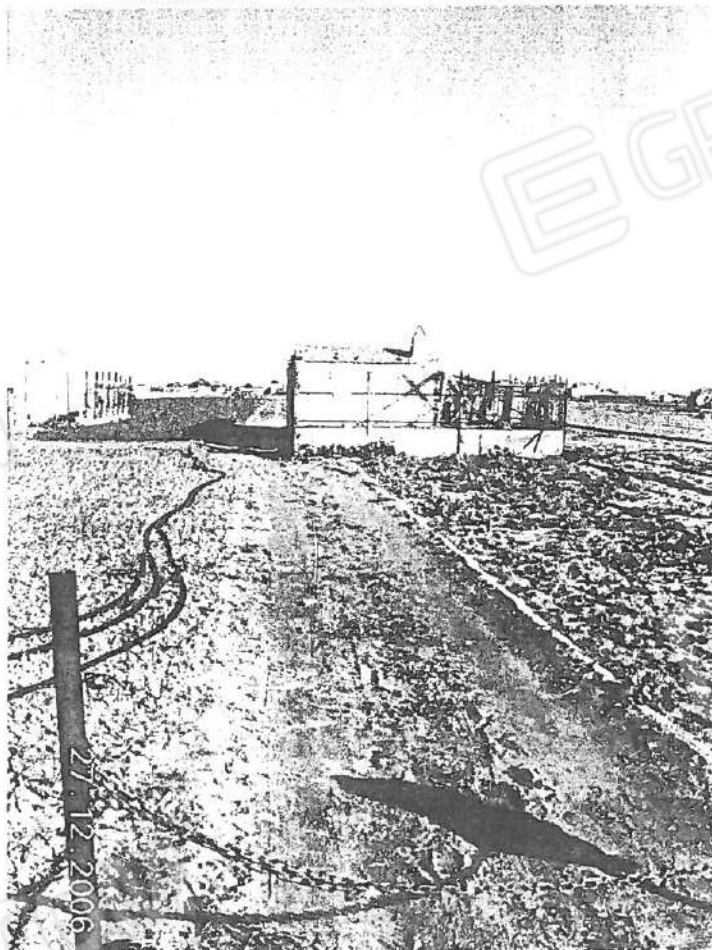
- Beni nn. 7 e 8 – 6° Lotto - Vista esterna -
