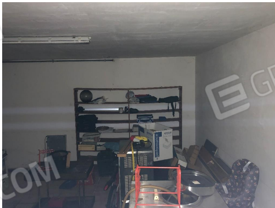
Foto n. 8: Locale autorimessa sub. 13
