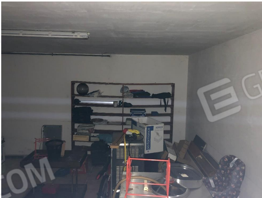
Foto n. 6: Locale autorimessa sub. 13
