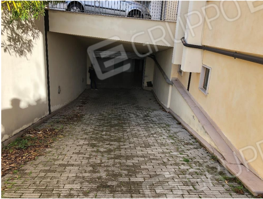
Foto n. 3: Rampa d'accesso all'area di manovra
