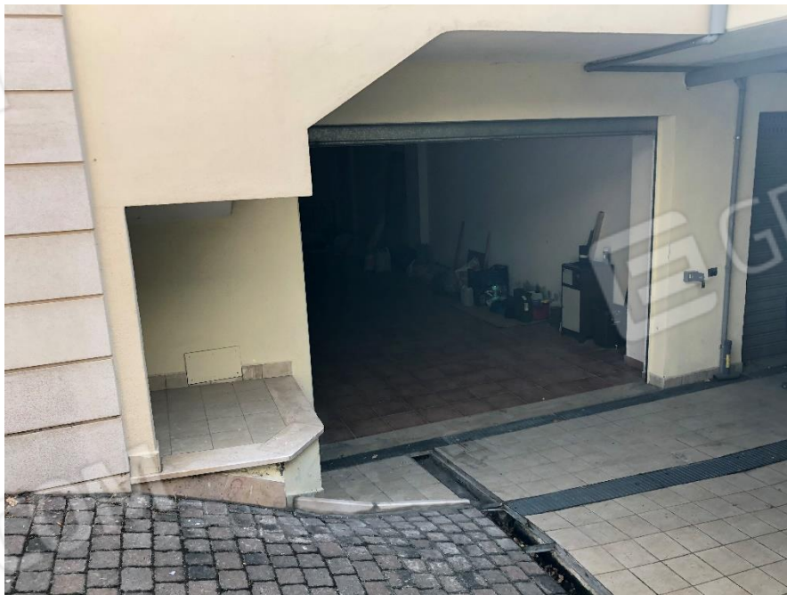
Foto n. 4: Ingresso locale autorimessa
