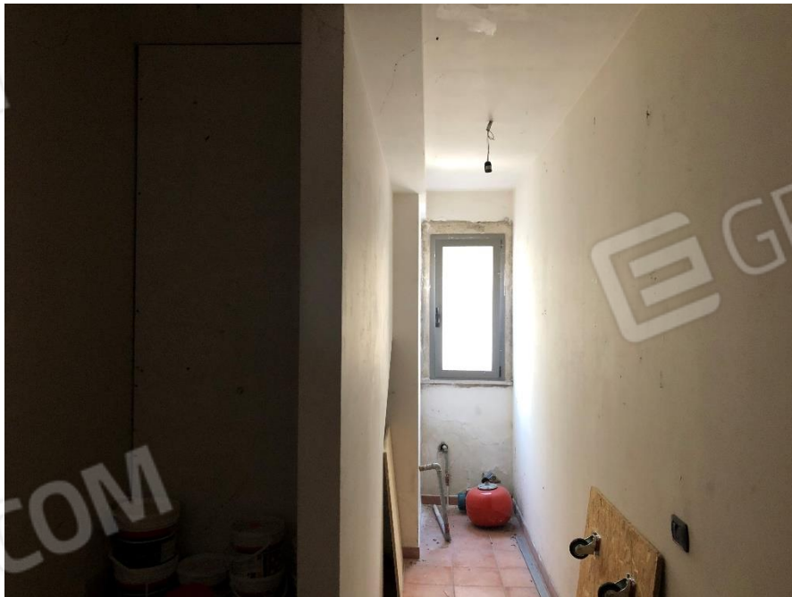
Foto n. 8: Vano scala murato (a sinistra) e finestra adiacente l'ingresso dell'autorimessa
