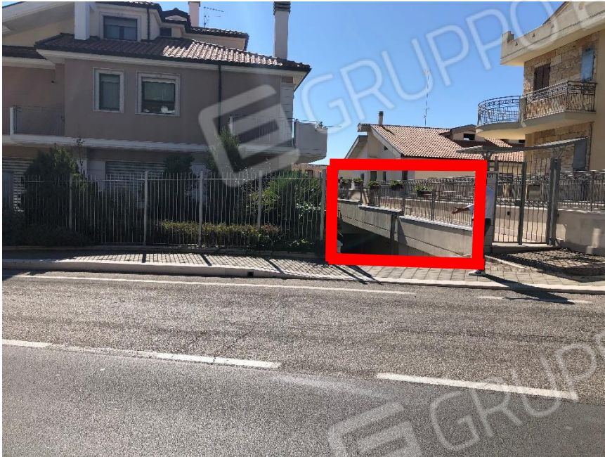
Foto n. 1: Ingresso bene oggetto di stima piano terra – Viale Aldo Moro n. 129 b
