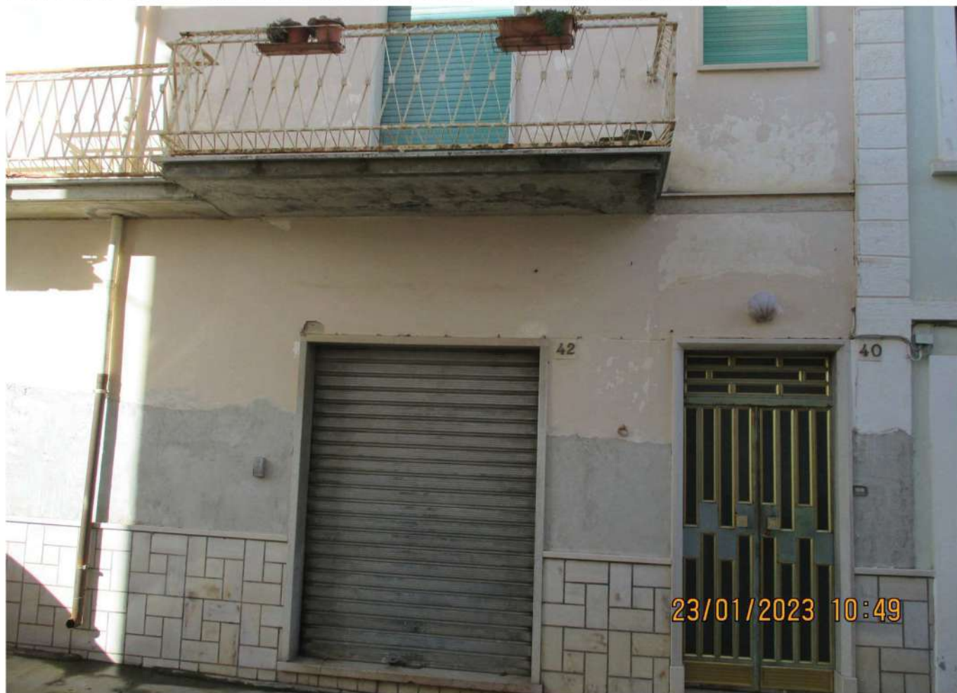
FOTO N°1 - FACCIATA ESTERNA PRINCIPALE CON INGRESSO CIVICO 40
