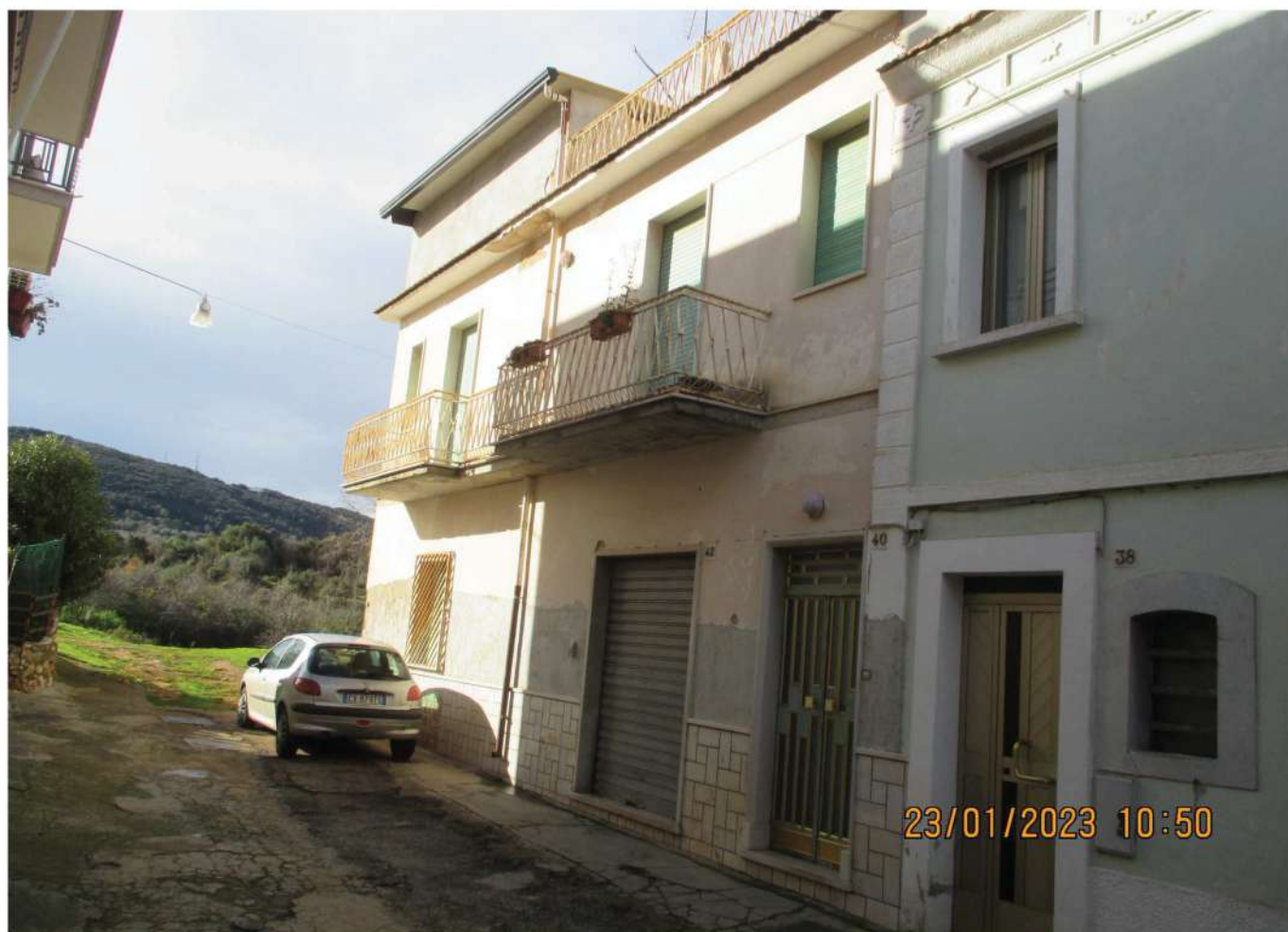
FOTO N°2 - FACCIATA ESTERNA PRINCIPALE
