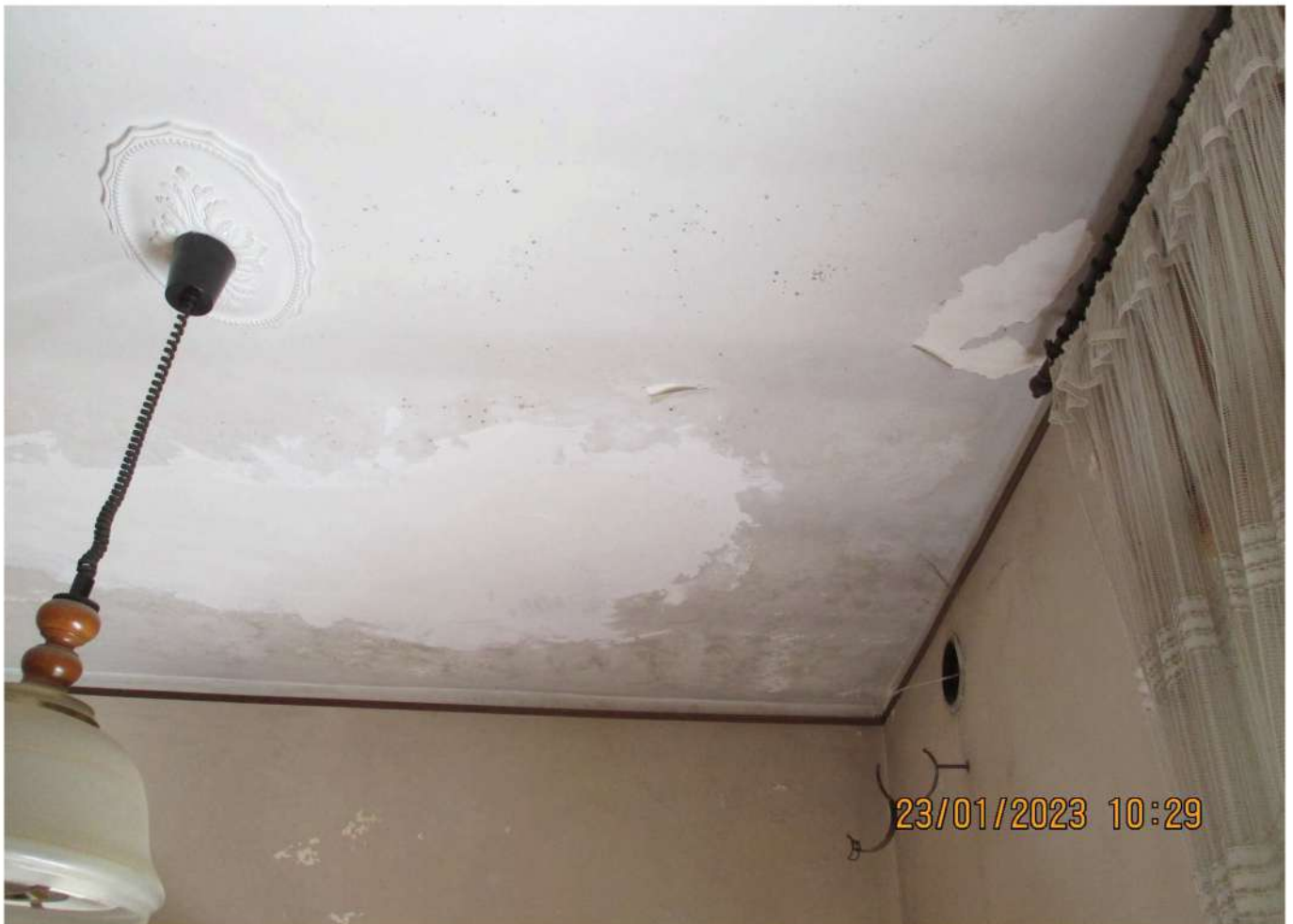
FOTO N°20 - VISTA SOFFITTO DELLA CUCINA
