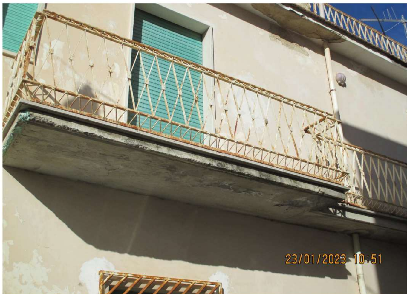
FOTO N°4 - VISTA BALCONE 1° P.
