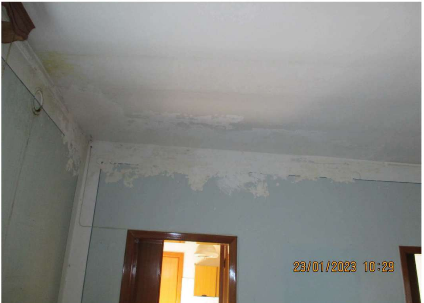
FOTO N°22 - VISTA SOFFITTO DEL SOGGIORNO
