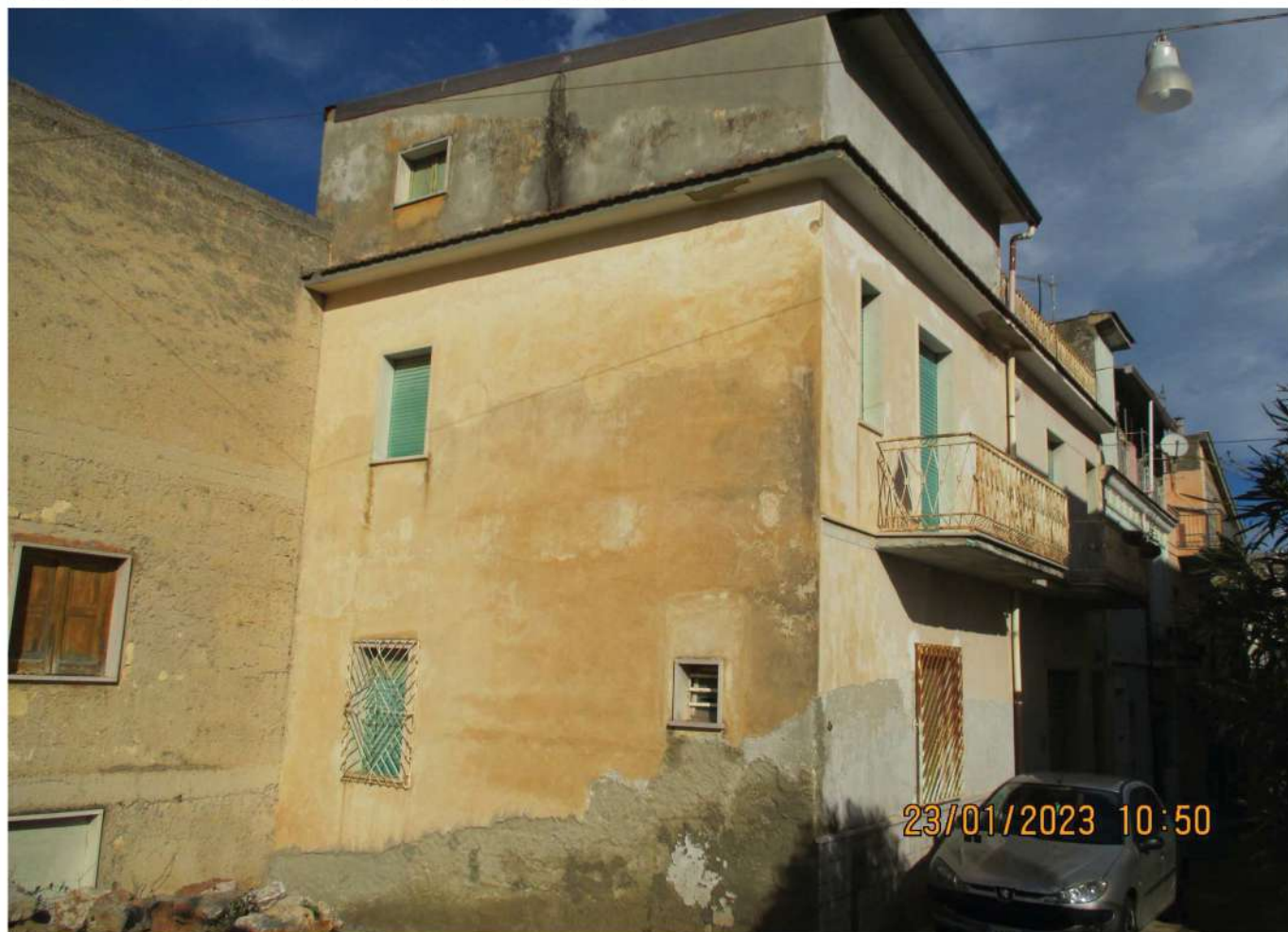
FOTO N°3 - FACCIATA ESTERNA LATERALE
