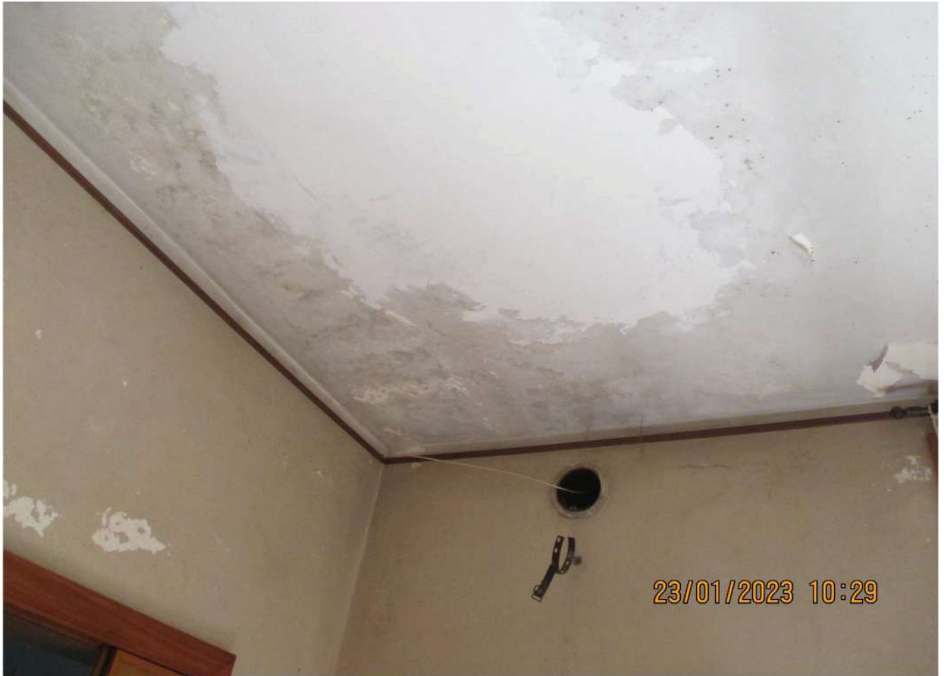
FOTO N°21 - VISTA SOFFITTO DELLA CUCINA
