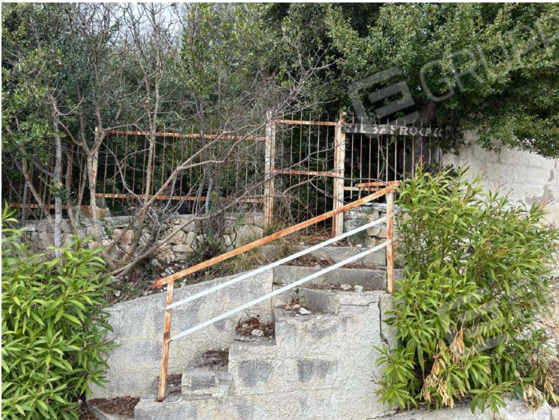
Foto n. 10 – Ingresso principale dell'immobile (interno 37)
