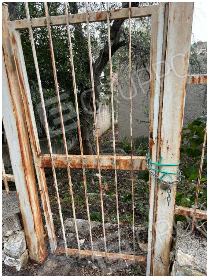
Foto n. 3 – Ingresso posteriore all'immobile
