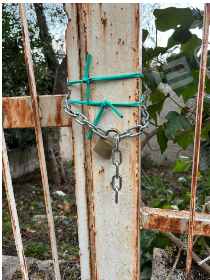
Foto n. 4 – Particolare dell'ingresso posteriore all'immobile
