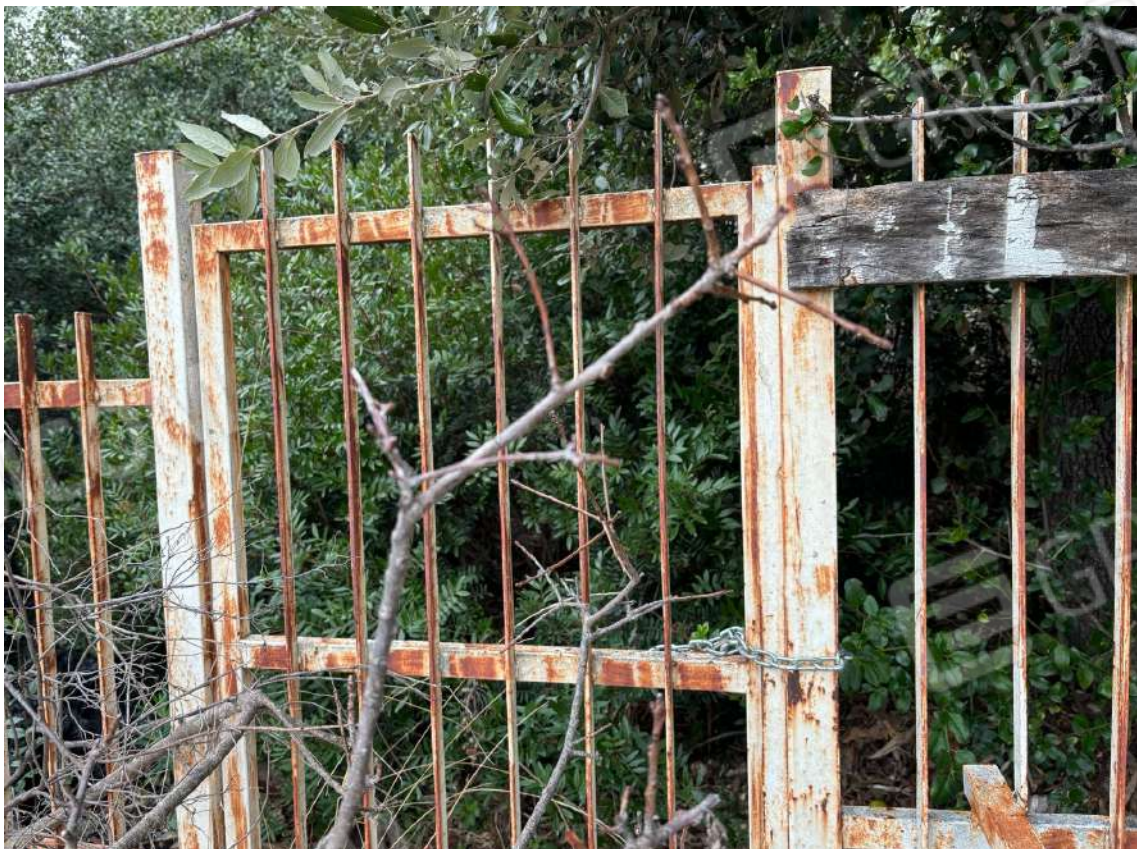
Foto n. 12 – Ingresso principale dell'immobile
