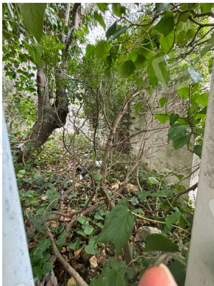
Foto n. 16 – Particolare dell'area circostante sul prospetto laterale (ovest) dell'immobile
