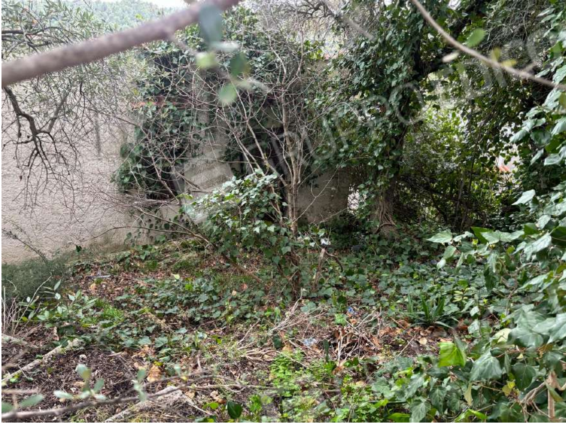
Foto n. 9 – Prospetto posteriore dell'immobile
