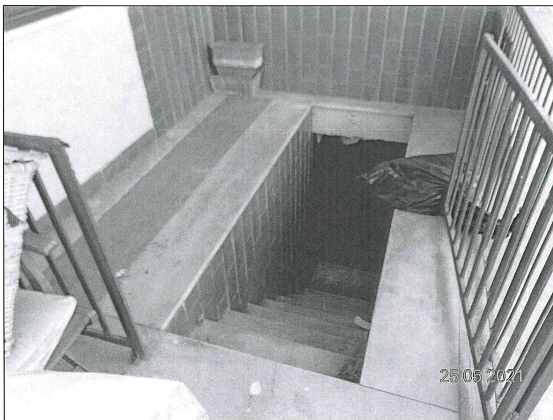
Foto A.4. Scalinata per l'accesso al locale deposito interrato.
