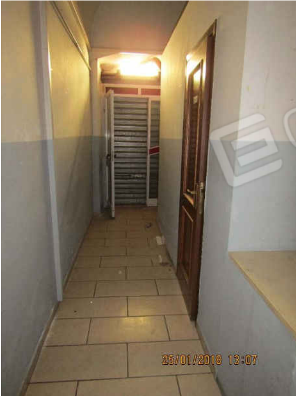
FOTO N. 33 – Locali commerciali al piano terra, particolare interno. Comune di San Ferdinando di Puglia (BT) Fgl. 13 p.lla 450 sub. 1, sub. 4.
