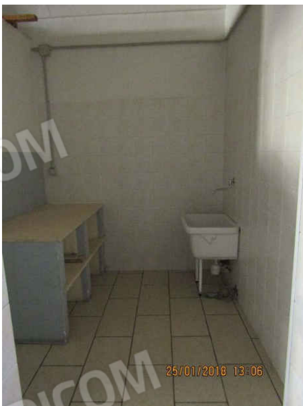
FOTO N. 32 – Locali commerciali al piano terra, particolare interno. Comune di San Ferdinando di Puglia (BT) Fgl. 13 p.lla 450 sub. 1, sub. 4.
