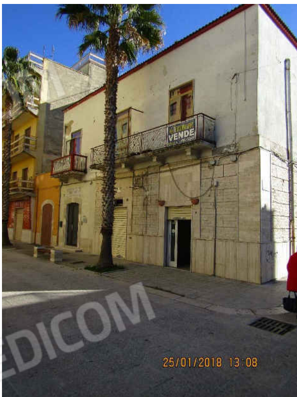
FOTO N. 30 – Vista prospettica locali commerciali posti al piano terra dell’edificio sito in Via XXIV Maggio.
