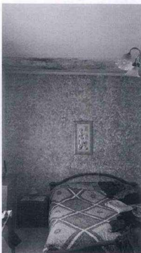
La camera da letto con infiltrazioni e muffa, dell'abitazione al lotto 2 p.lla 307 sub 5
