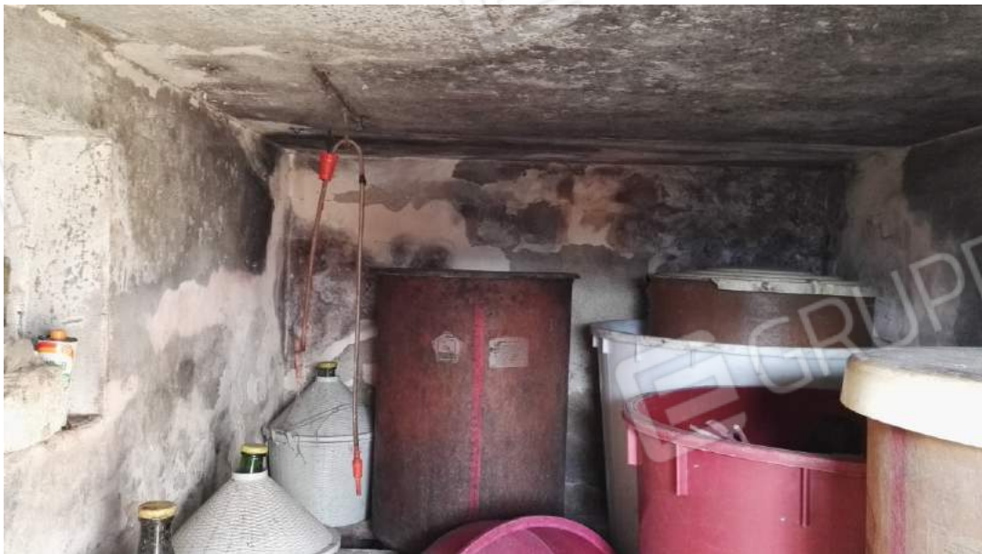
Interno del sub 2 del lotto 2
