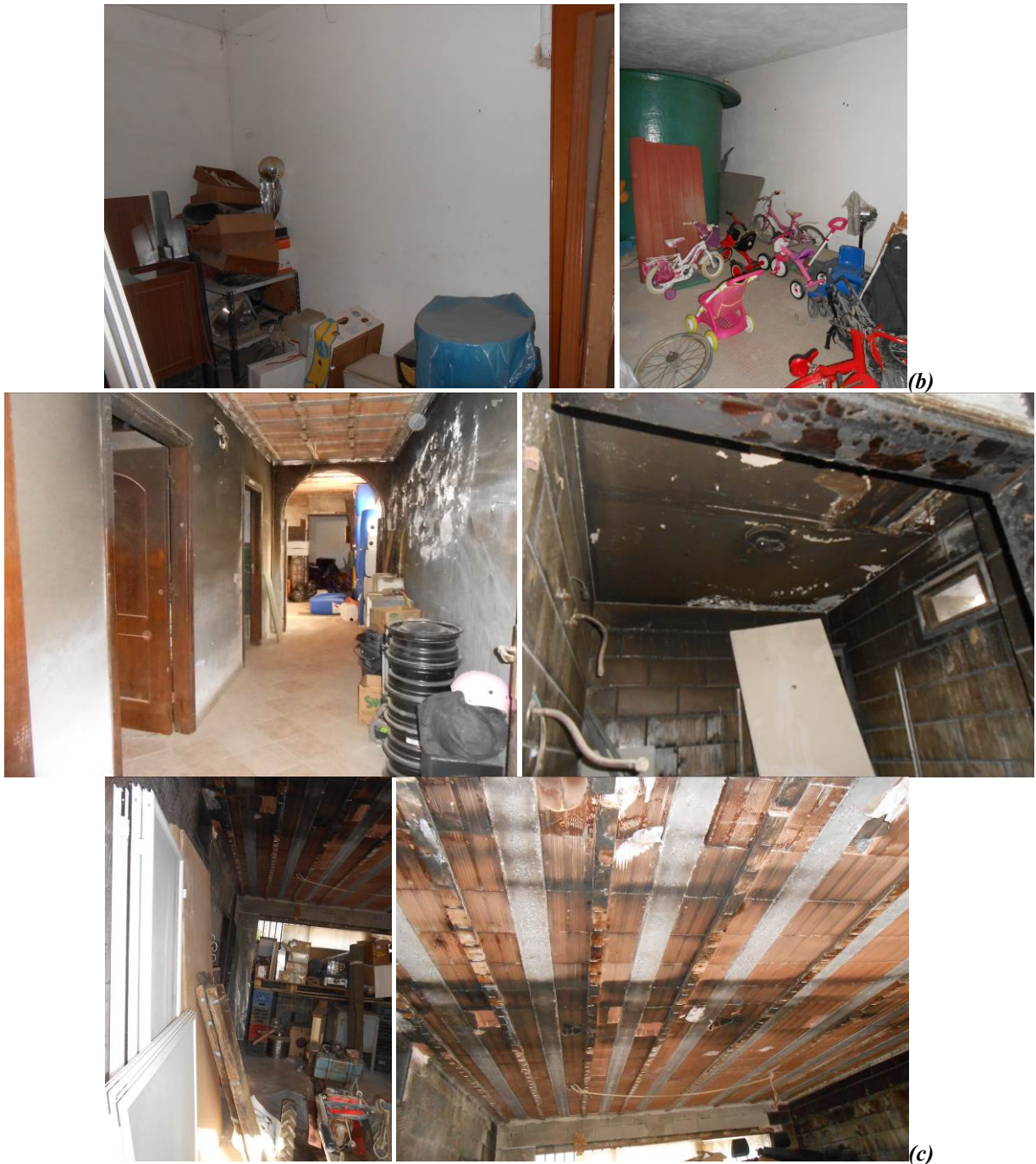
Figura n° 9. Fotografie del deposito in piano seminterrato: portone di accesso (a); ambienti e locali interni non danneggiati dall'incendio (b); locali e accessori interni danneggiati dall'incendio (c).
