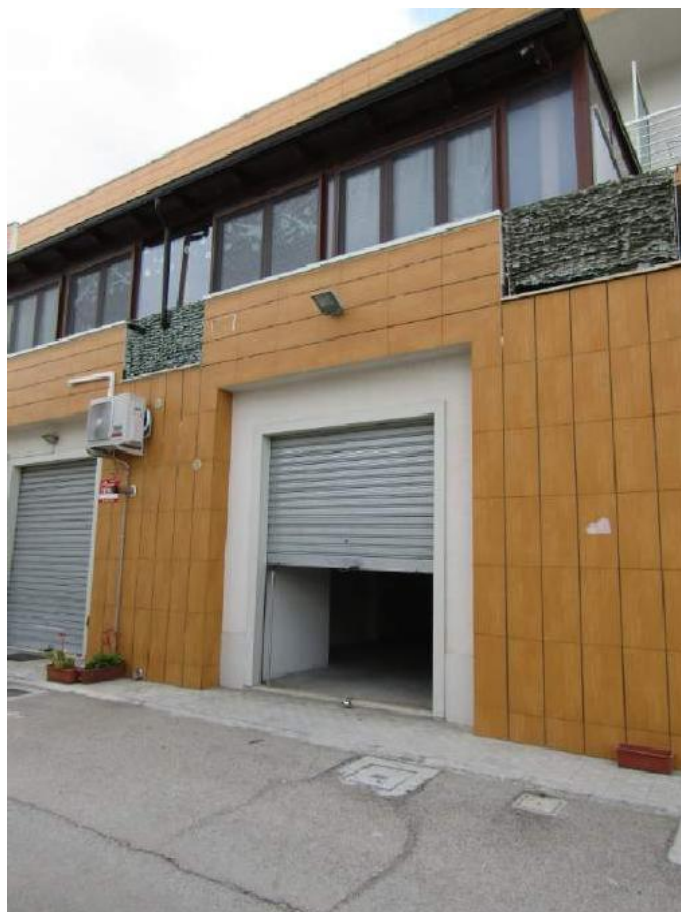
FOTO 5.2 - LOTTO 5 - LABORATORIO ARTIGIANALE IN FOGGIA - INGRESSO
