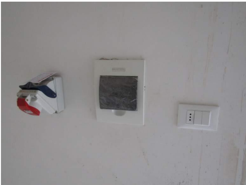
Foto 5.5 - LOTTO 5 - LABORATORIO ARTIGIANALE IN FOGGIA - INTERNO
