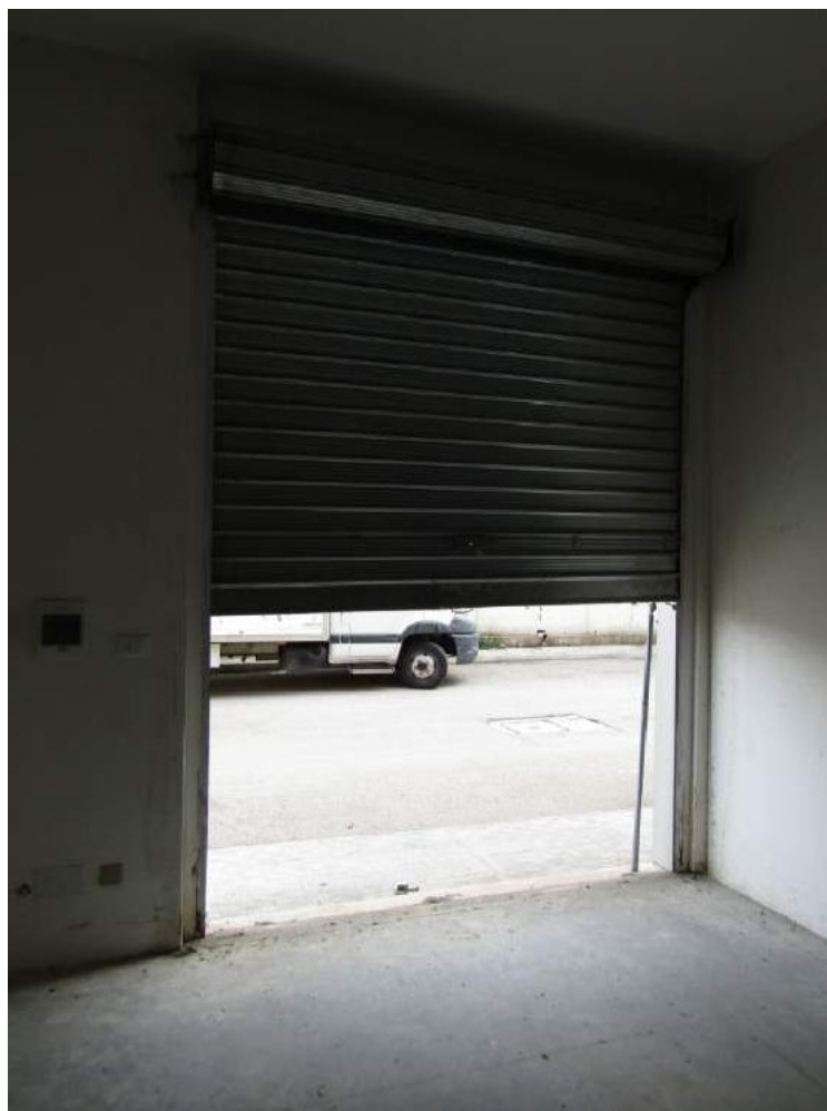
FOTO 5.3 - LOTTO 5 - LABORATORIO ARTIGIANALE IN FOGGIA - INGRESSO
