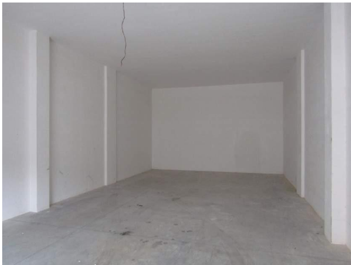
FOTO 5.4 - LOTTO 5 - LABORATORIO ARTIGIANALE IN FOGGIA - INTERNO
