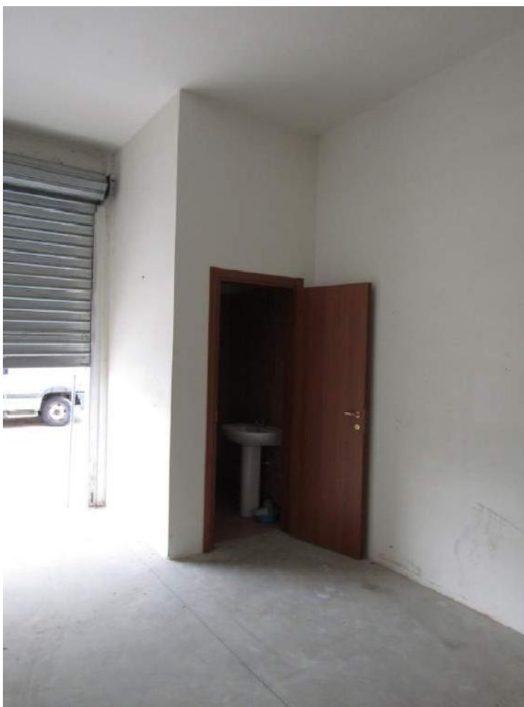
Foto 5.6 - LOTTO 5 - LABORATORIO ARTIGIANALE IN FOGGIA - INTERNO
