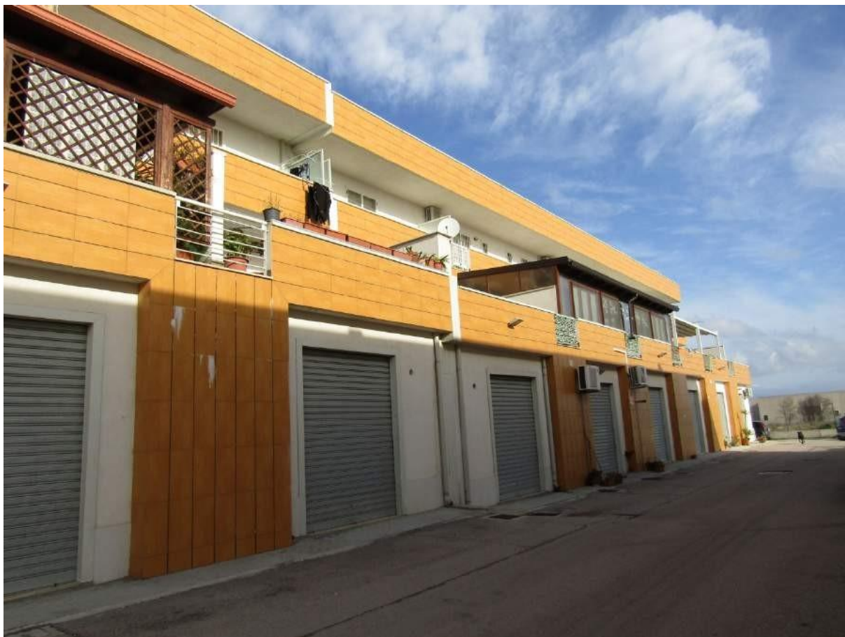
FOTO 6.1 - LOTTO 6 - LABORATORIO ARTIGIANALE IN FOGGIA - FABBRICATO B
