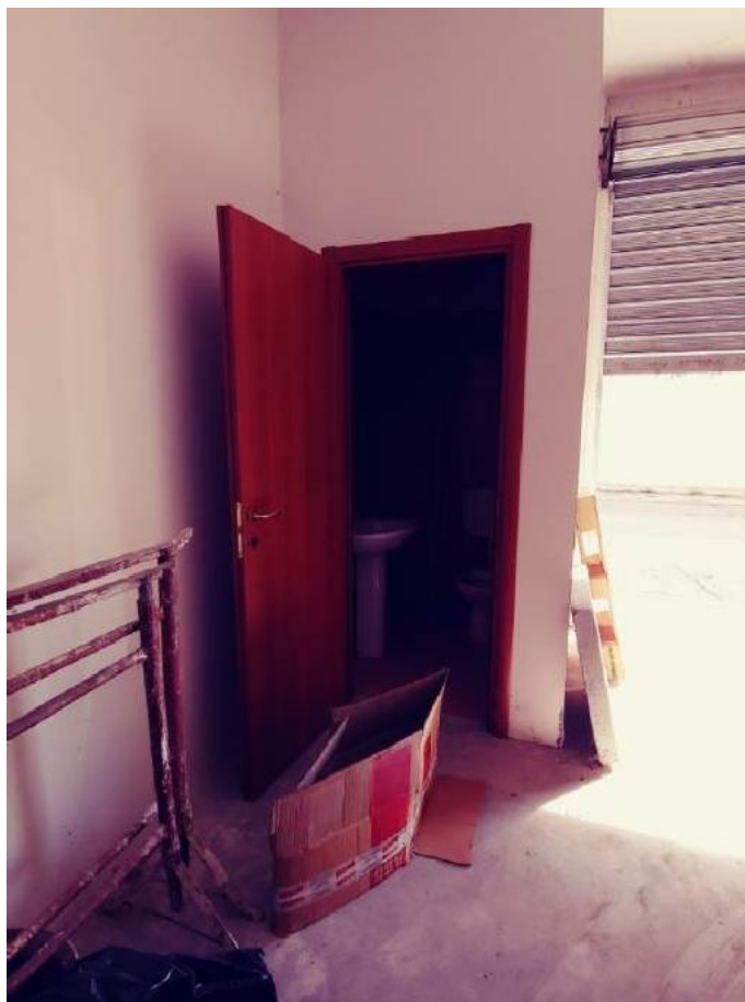
FOTO 6.7 - LOTTO 6 - LABORATORIO ARTIGIANALE IN FOGGIA - BAGNO
