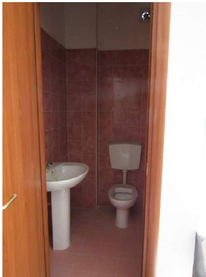
FOTO 6.8 - LOTTO 6 - LABORATORIO ARTIGIANALE IN FOGGIA - BAGNO
