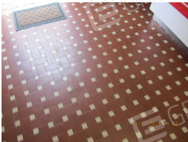
FOTO N° 75: VISTA TIPOLOGIA DELLA PAVIMENTAZIONE RILEVATA AL SUO INTERNO.
