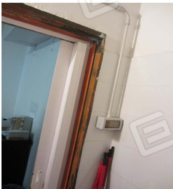
FOTO N° 81: VISTA GENERALE DEL W.C. RILEVATO AL SUO INTERNO DA PARTE OPPOSTA ALLE DUE PRECEDENTI FOTO.
