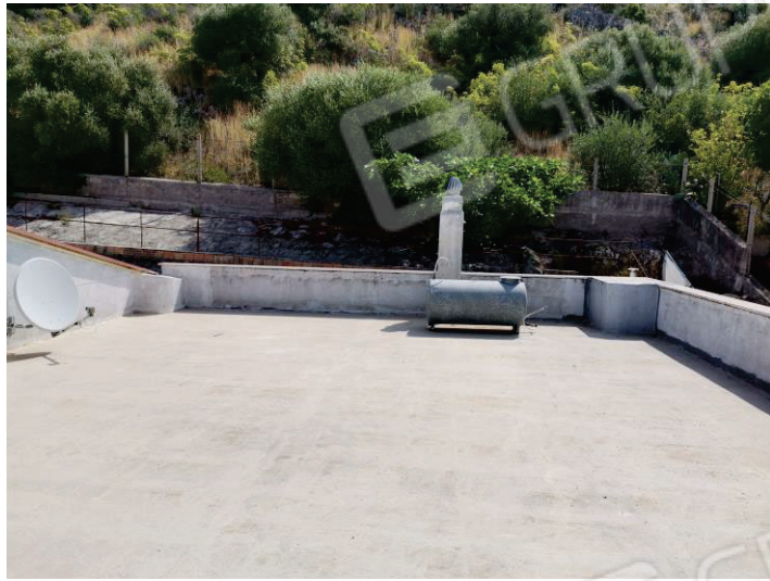
LOTTO 4 il lastrico solare sub 8
