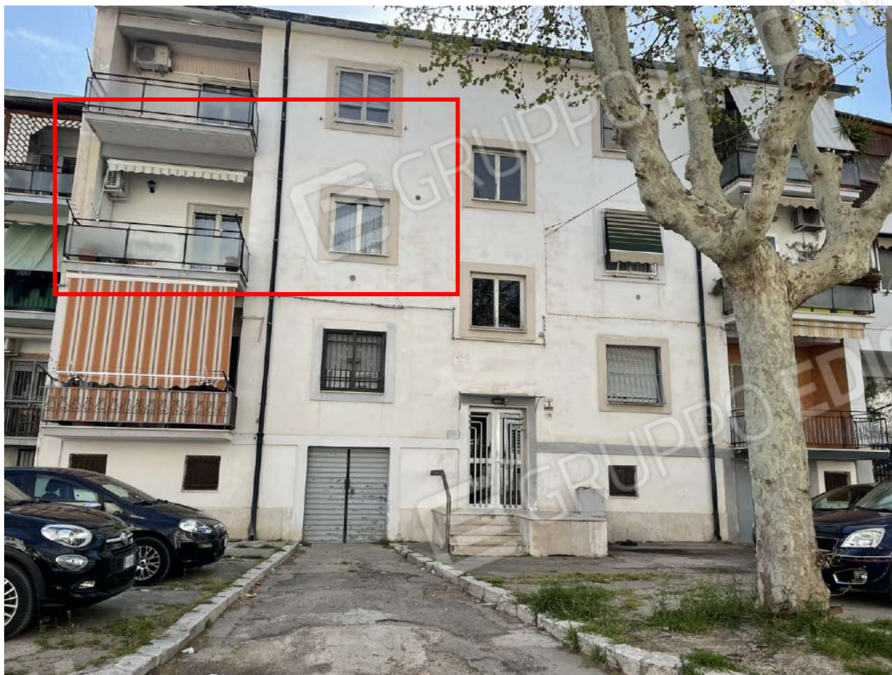
Figura 3. LOTTO UNICO: Fabbricato in cui si trova l'immobile pignorato al F. 30, P.IIa 260, Sub. 16 ubicato in San Severo alla Via Giulio Cesare n. A/18.
