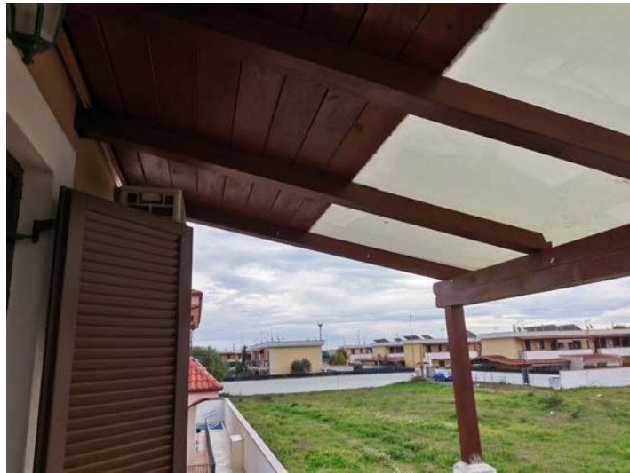
La tettoia sul balcone
