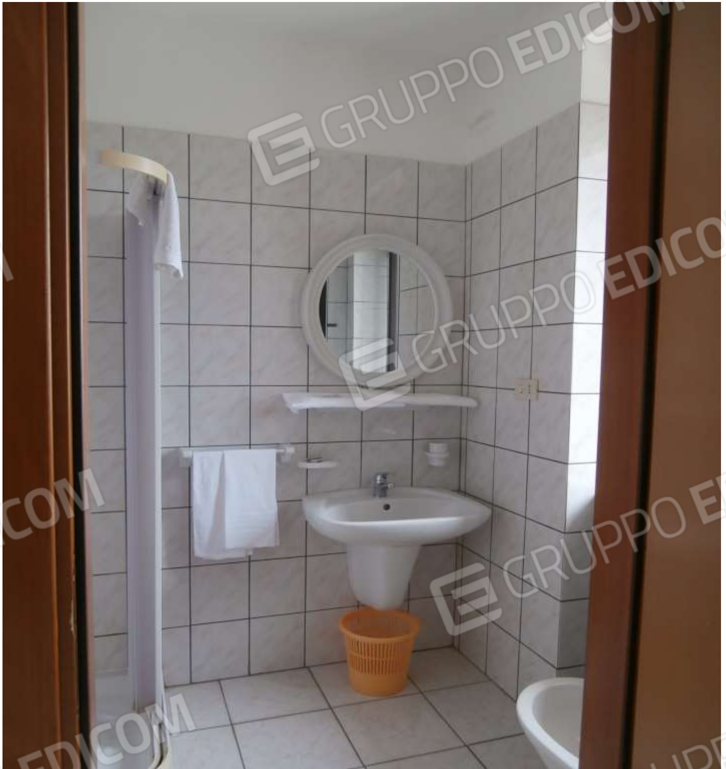
FOTO F.I.II.18A: il bagno della camera n.25 a piano secondo dell'Hotel, in evidenza: la porta in legno noce del tipo tamburato, la pavimentazione ed i rivestimenti in materiali ceramici, gli impianti elettrici del tipo sottotraccia, le pareti ed i soffitti intonacati a civile e tinteggiati con idropitture murali, le apparecchiature igienico-sanitarie con accessori in ottone cromato.
