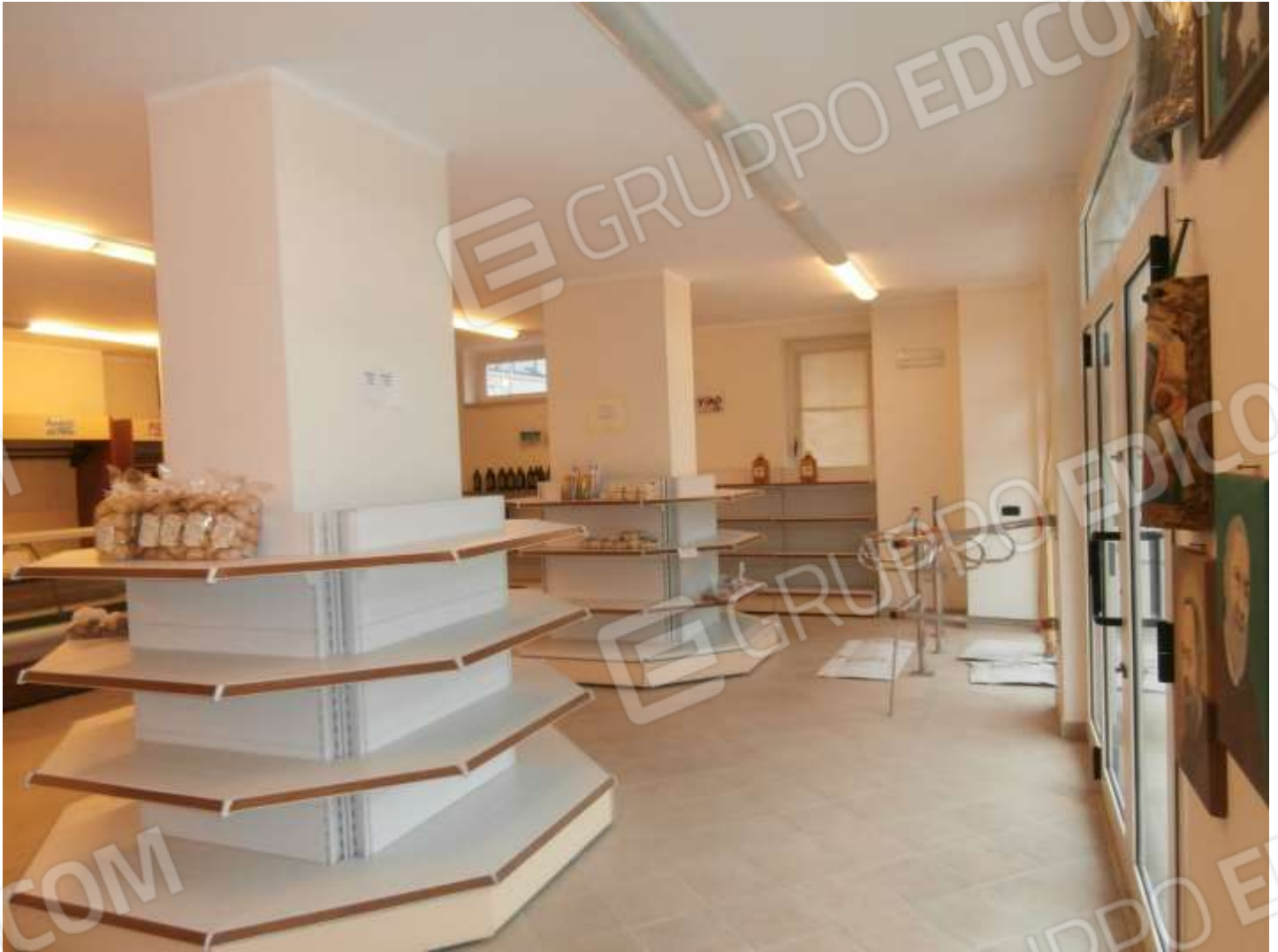
FOTO F.II.1: il negozio lotto II, in evidenza: l'ampia vetrata di accesso-illuminazione ed aerazione, la struttura in c.a. con pilastri e travi in spessore di solaio, l'impianto elettrico del tipo sottotraccia, la pavimentazione ed i battiscopa in materiale ceramico (gres), intonaci a pareti e soffitti del tipo civile tinteggiati con idropittura murale.
