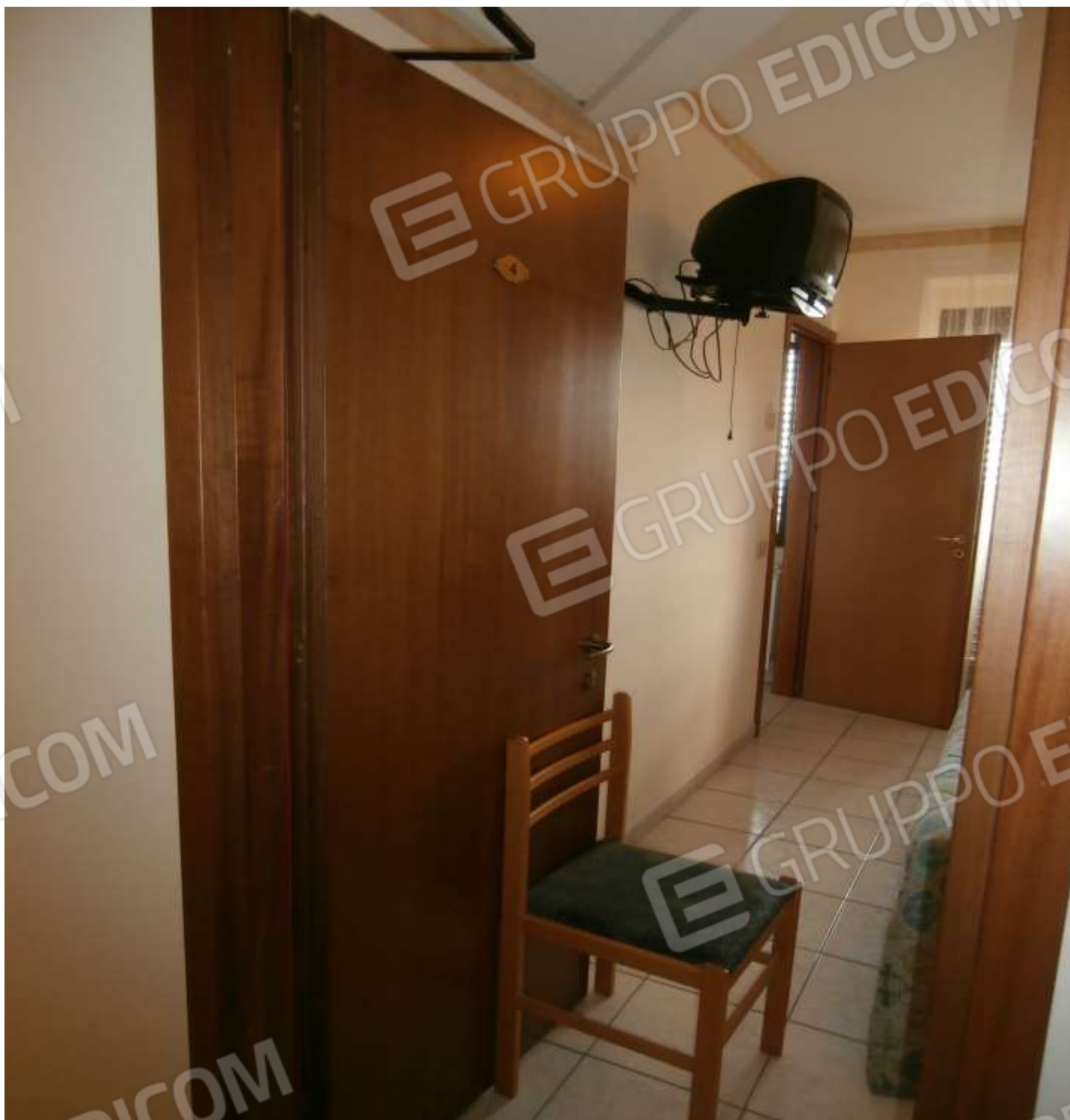
FOTO F.I.I.10: la camera n.4 a piano primo dell'Hotel, in evidenza: le porte in legno noce del tipo tamburato, la pavimentazione ed i battiscopa in materiali ceramici, gli impianti elettrici del tipo sottotraccia, le pareti intonacate a civile e tinteggiate con idropittura murali.
