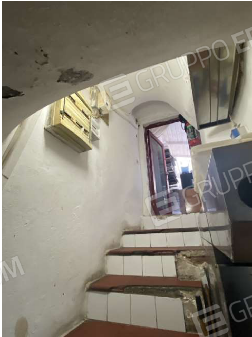
Foto 4) – Vista scale di ingresso da piano interrato IMMOBILE A
