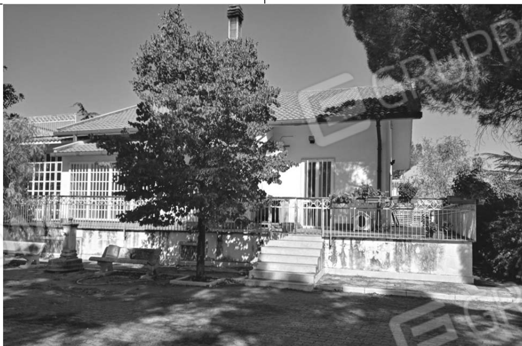
Fotografia 9 Prospetto Sud - balcone
