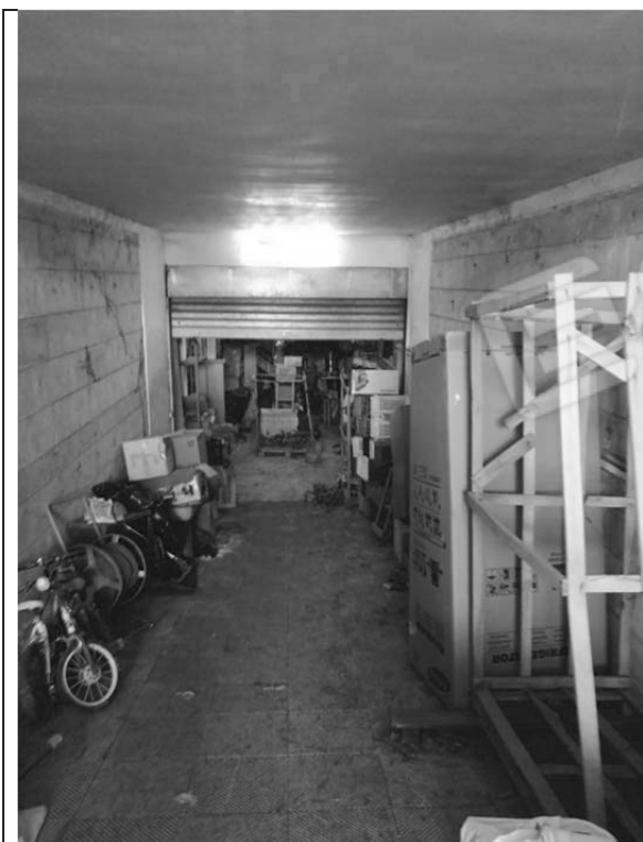
Fotografia 21 Rampa di accesso al garage
