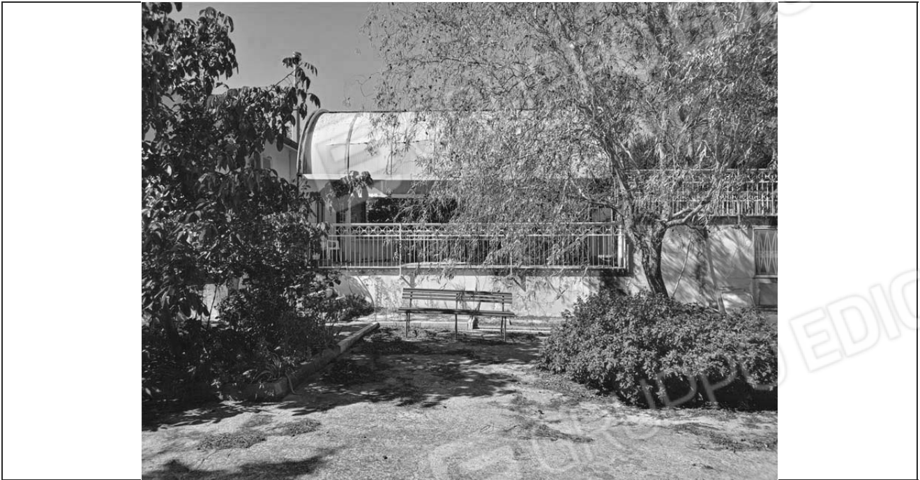
Fotografia 19 terrazzo a livelli sfalsato che copre la rampa di accesso al garage
