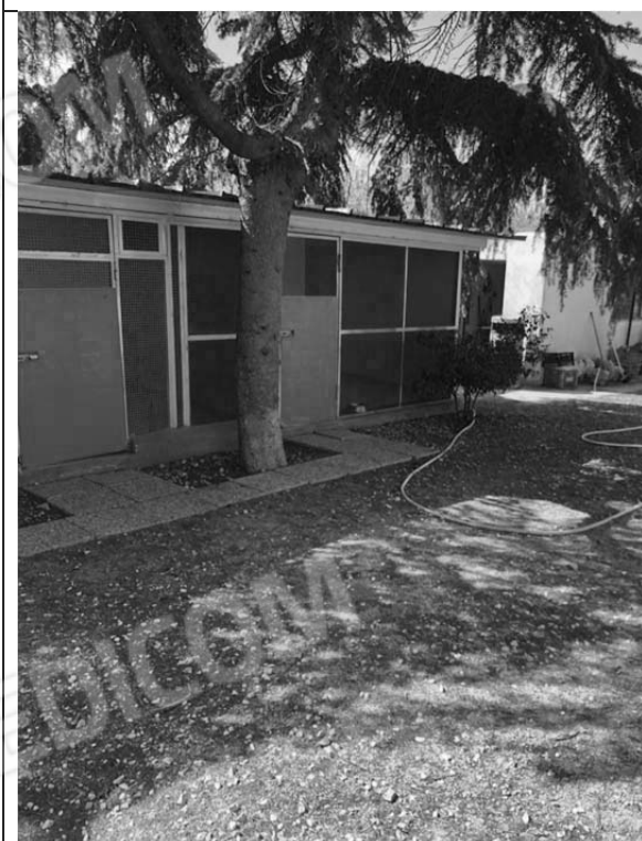
Fotografia 29 Manufatti lungo il confine Sud
