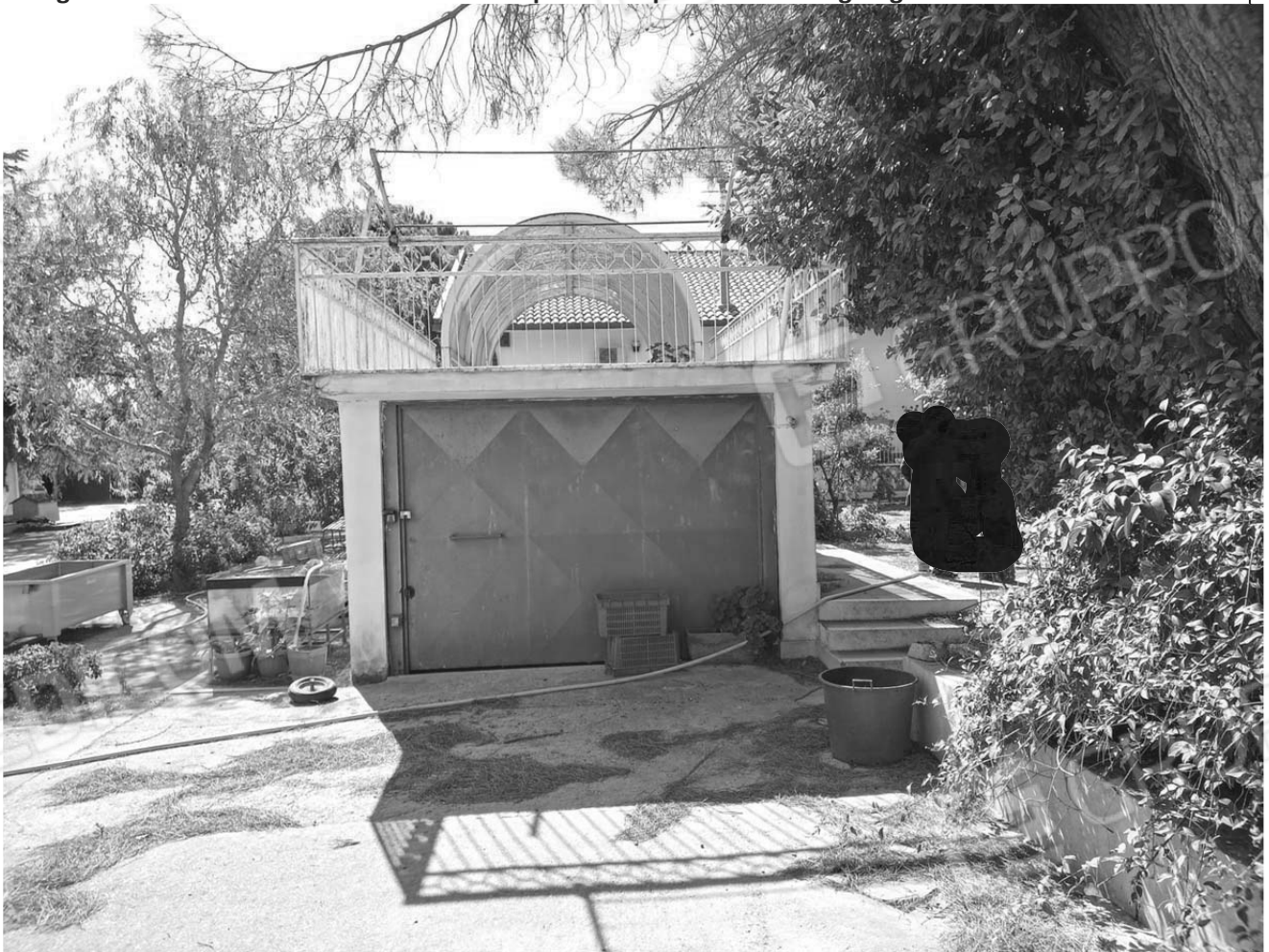
Fotografia 20 Ingresso alla rampa di accesso al garage
