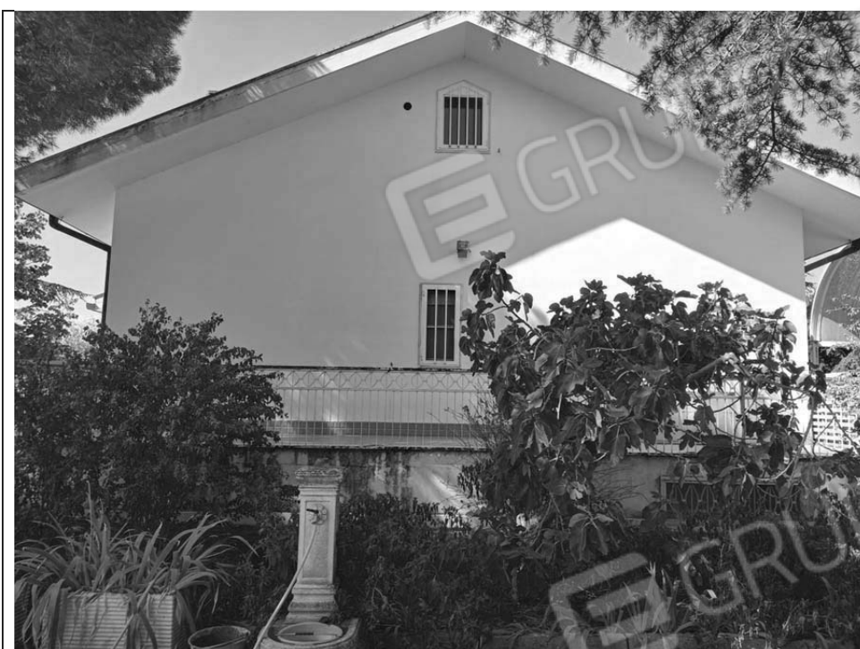
Fotografia 10 Prospetto Est- balcone
