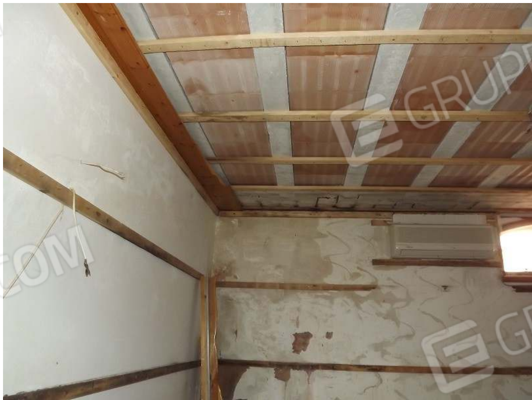
Corpo "B" – I° livello – infiltrazioni d'acqua con conseguente inagibilità san./
