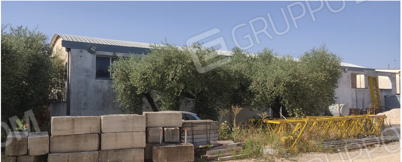
Vista esterna del capannone Foto n.5
