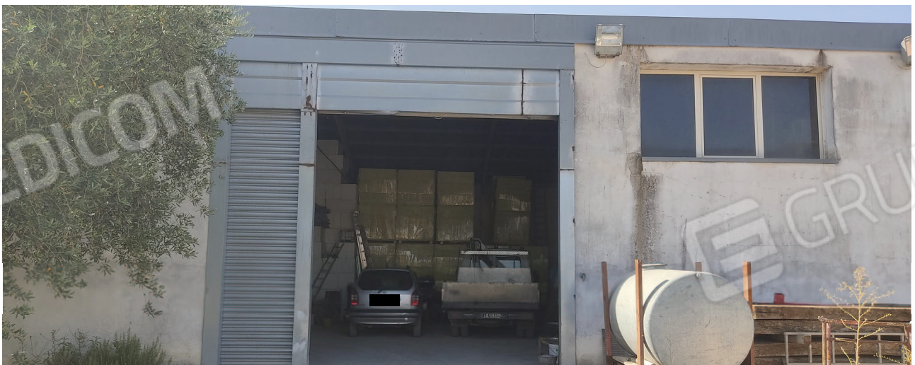
Ingresso del capannone Foto n.6
