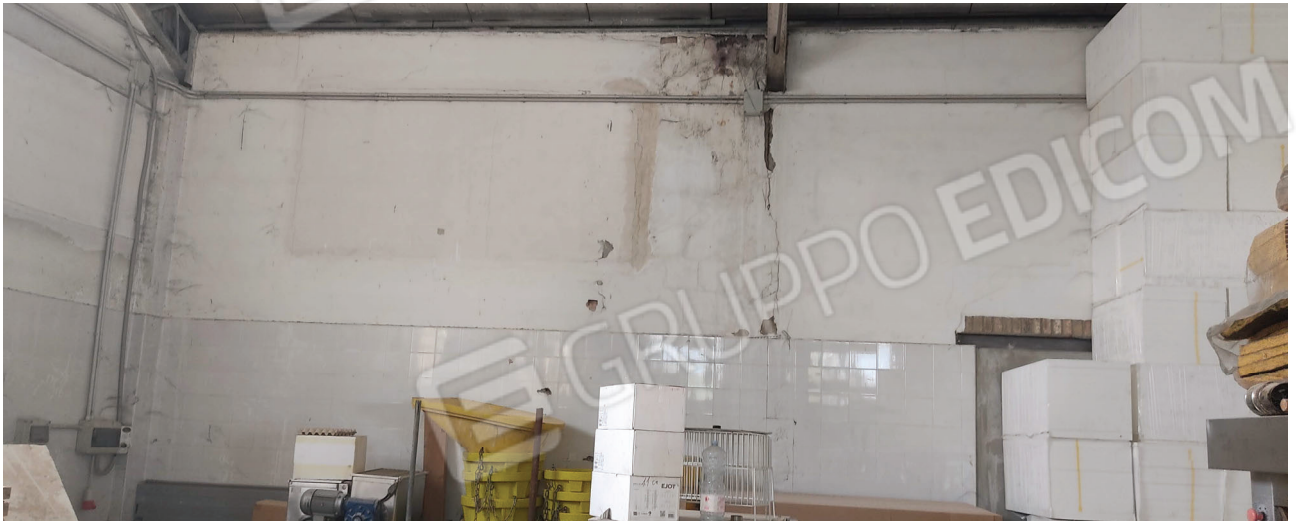
Vista interna del capannone Foto n.10
