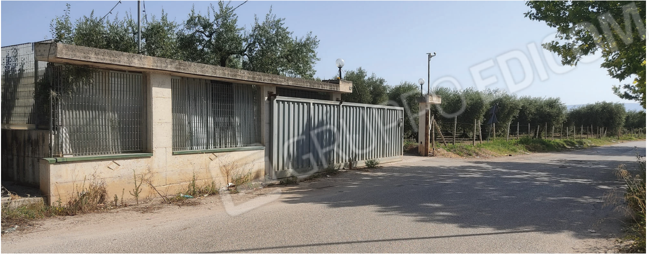
Ingresso su via Tanaro Foto n.1
