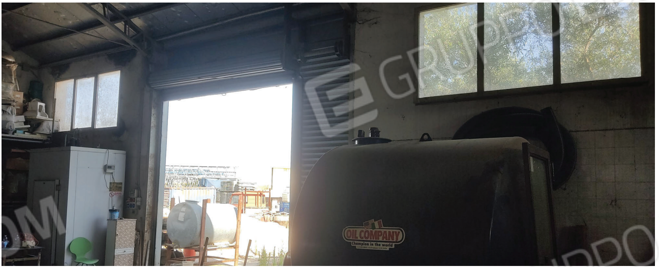
Vista interna del capannone Foto n.11
