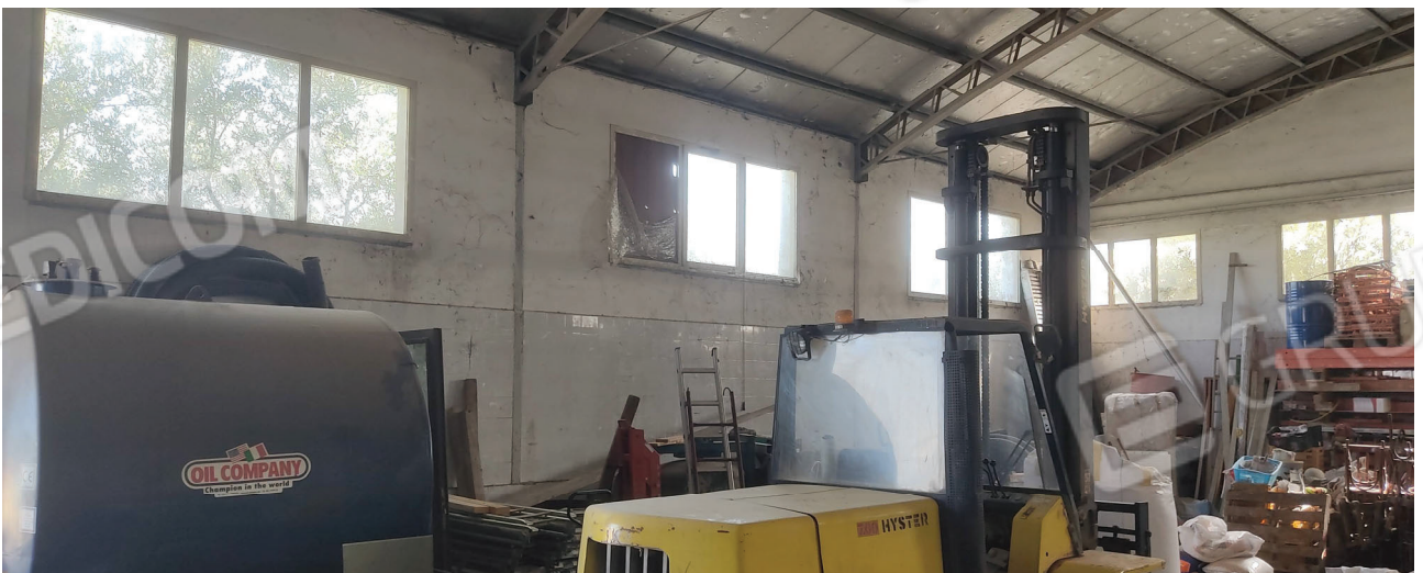
Vista interna del capannone Foto n.9
