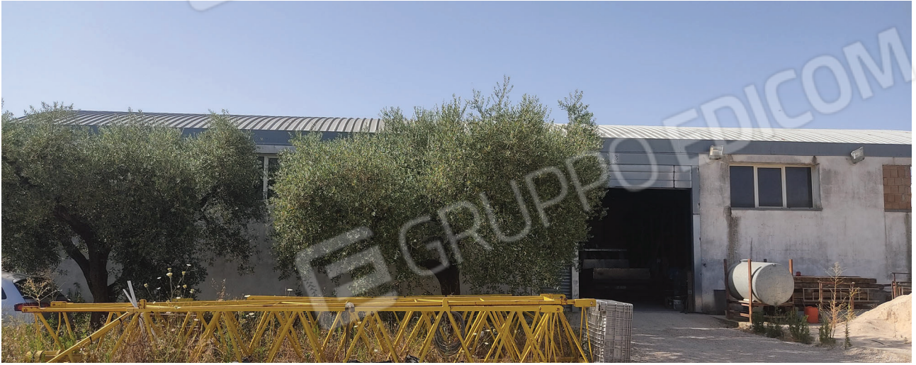
Ingresso del capannone Foto n.4
