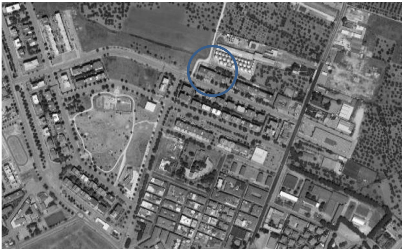
Figura n.1 (Inquadramento territoriale del fabbricato)
